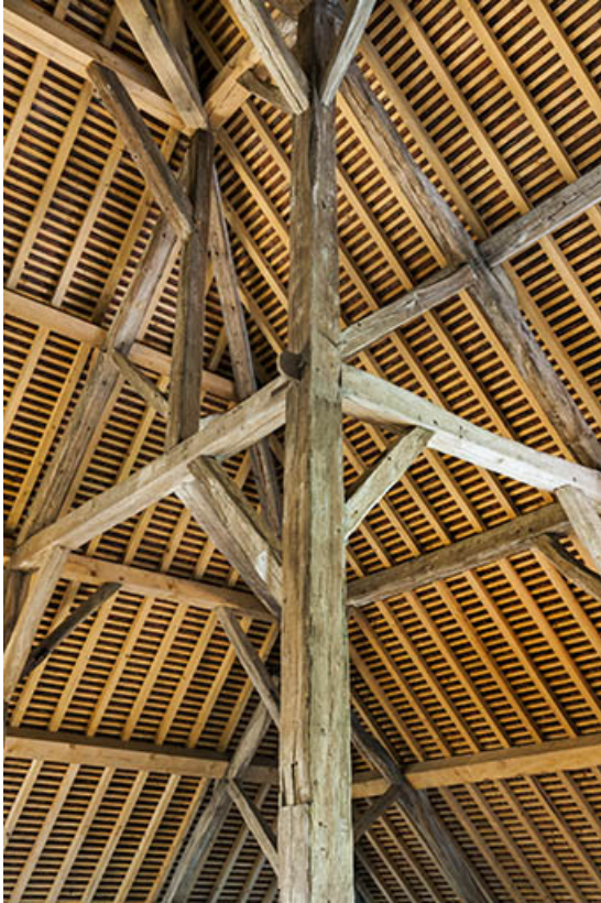
Charpente du séchoir. Détail de la croupe.
