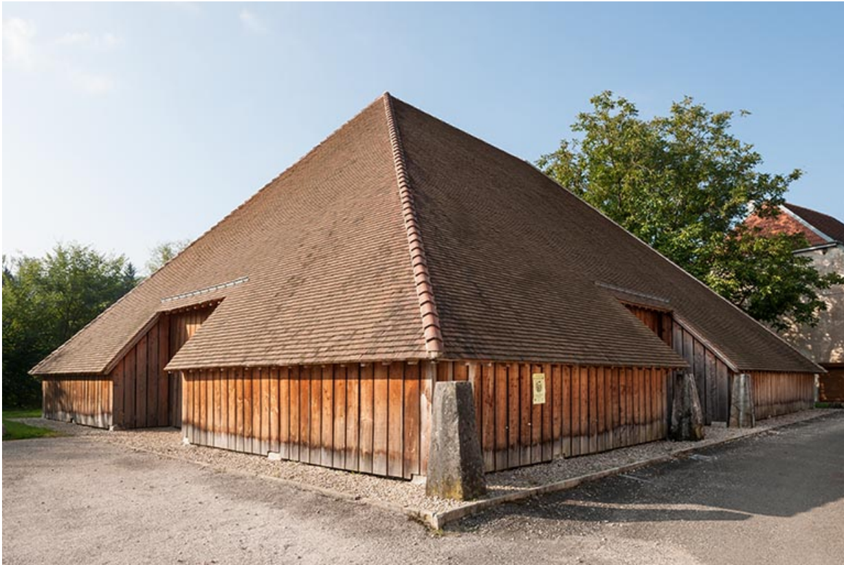
Vue de trois quarts depuis le chemin de Roche.
