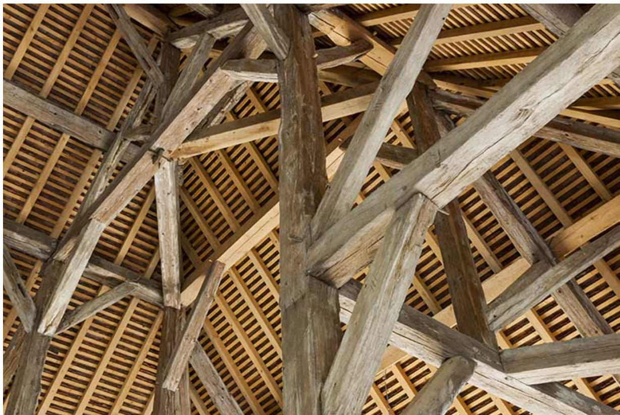
Croupe du séchoir. Partie supérieure de la charpente.
