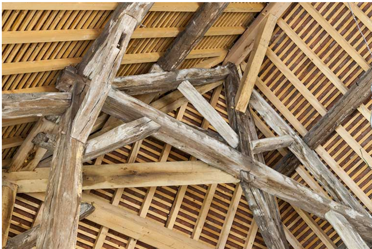
Détail de la charpente de la croupe.
