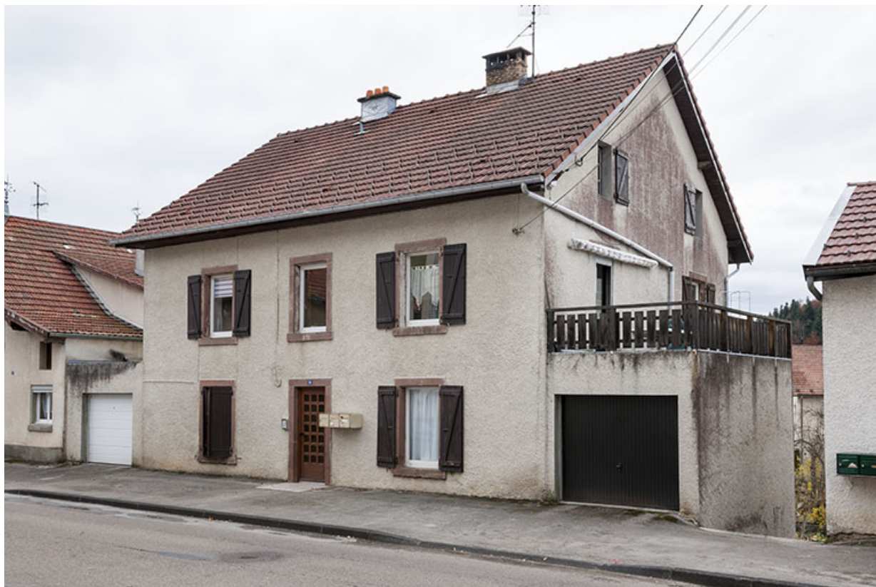
Façades antérieure et latérale droite.
