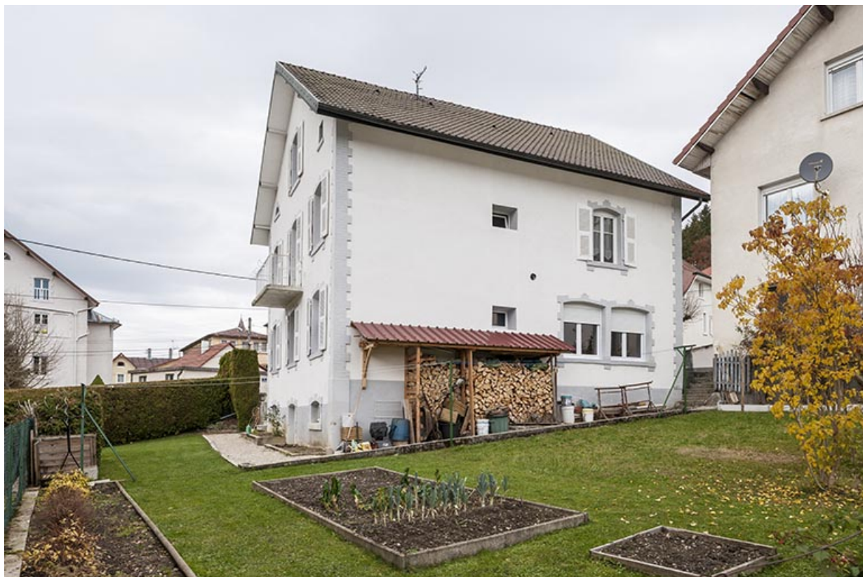
Façade postérieure, de trois quarts gauche. 25, Maîche, 12 rue du Mont
