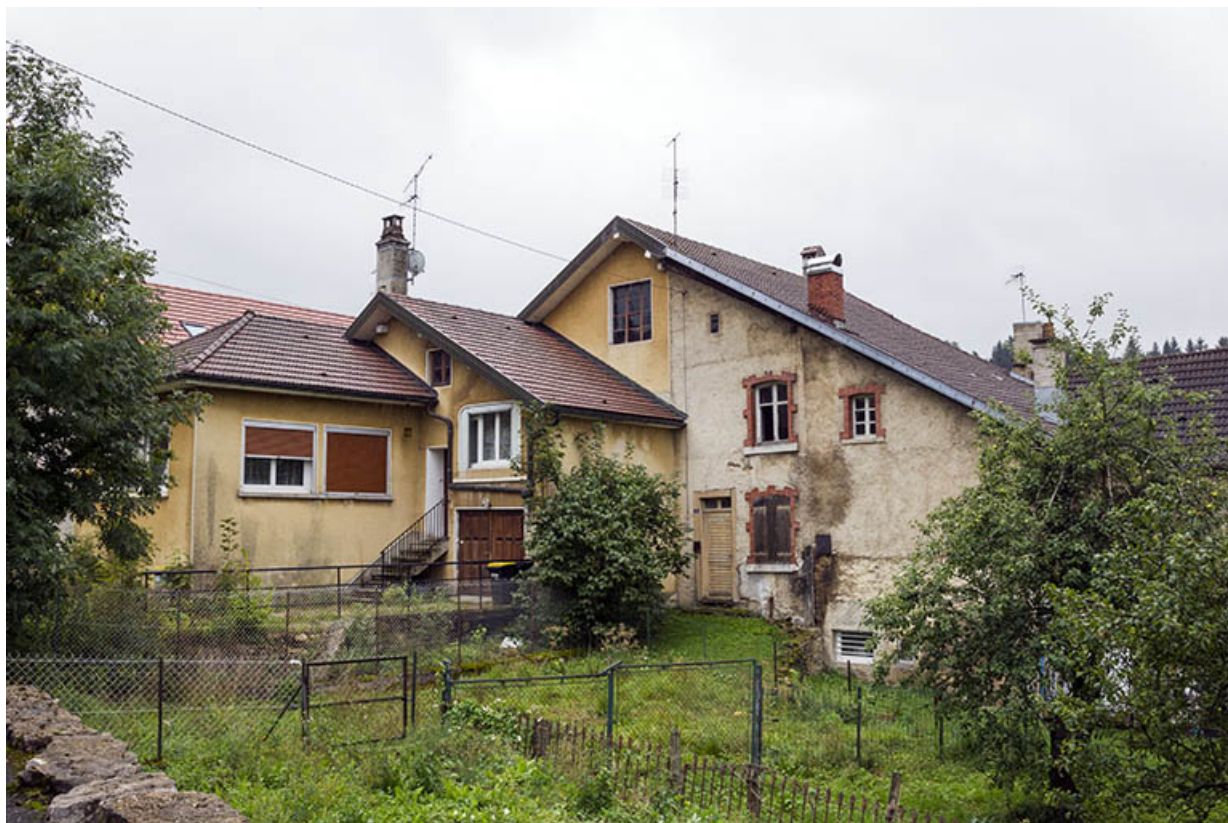
Vue d'ensemble, depuis le nord-ouest (façade postérieure).
