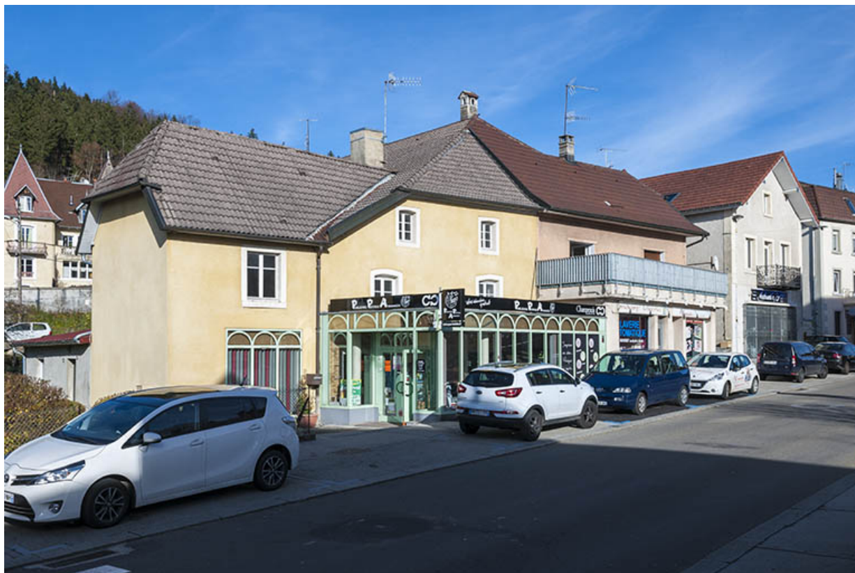
Vue d'ensemble, depuis le sud-ouest (façade antérieure). 25, Maîche, 17 et 19 rue Montalembert
