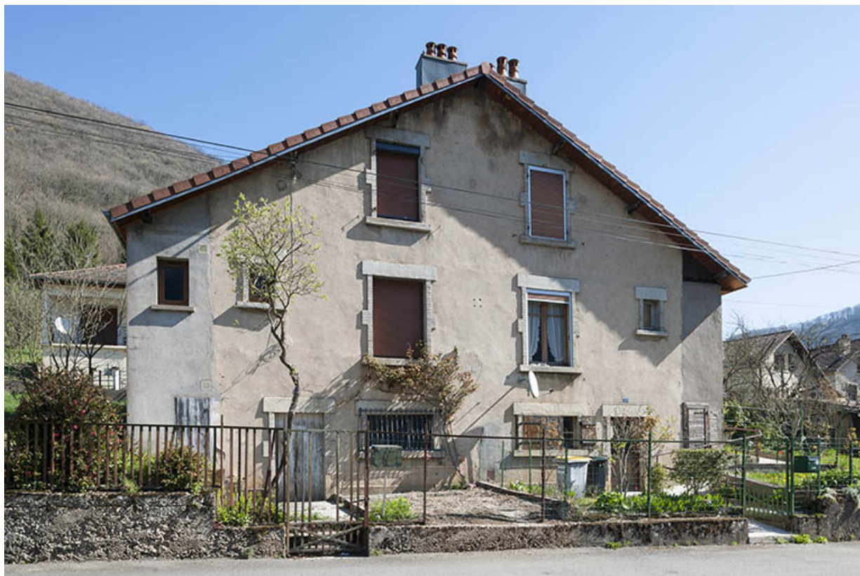
Façade antérieure d'une maison jumelée.
