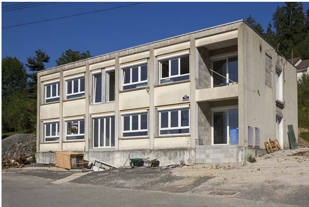
Façades antérieure et latérale droite, avant la transformation en immeuble. 25, Maîche, 13 rue Paul Monnot
