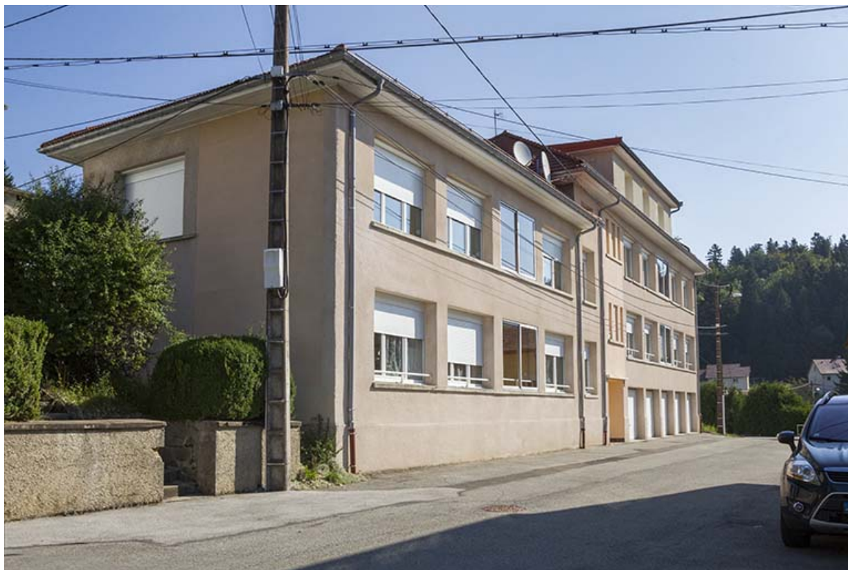
Vue d'ensemble, depuis l'ouest (façades antérieure et latérale gauche).
