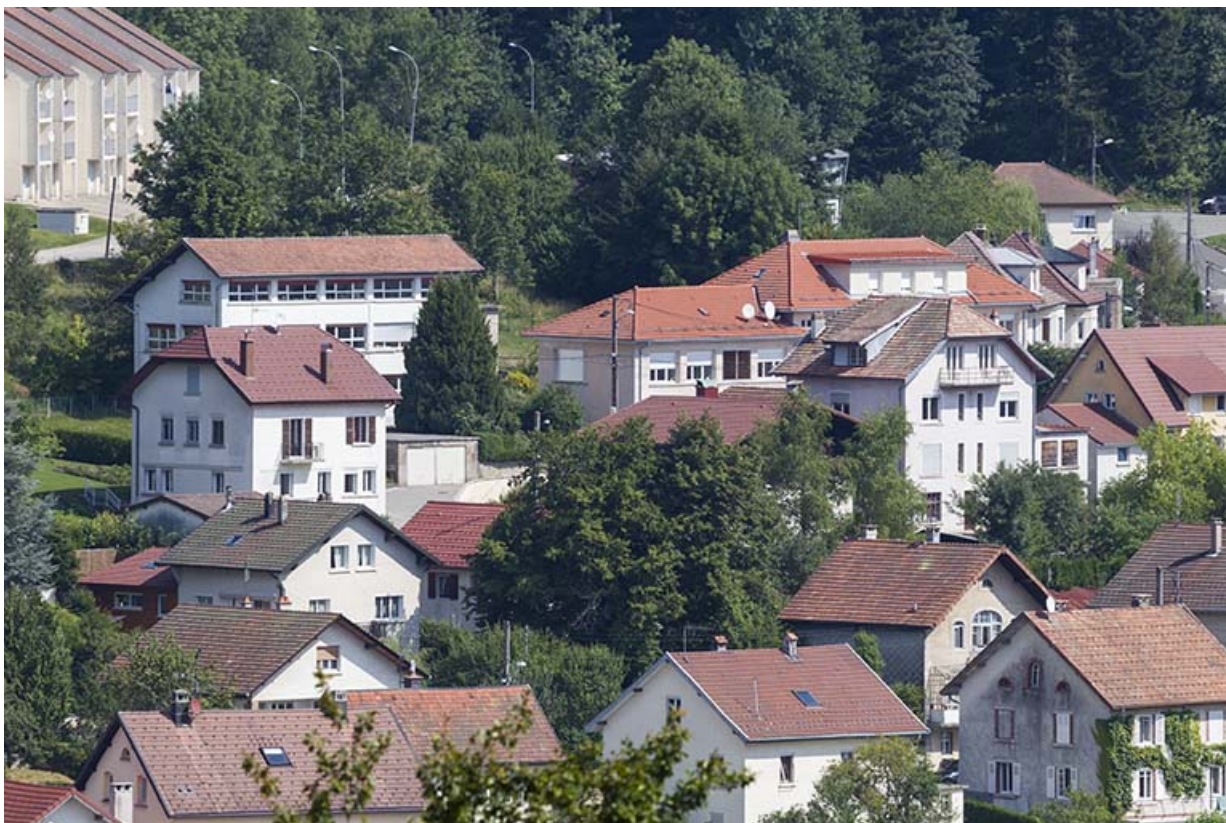
Vue d'ensemble, depuis le sud-ouest. 25, Maîche
