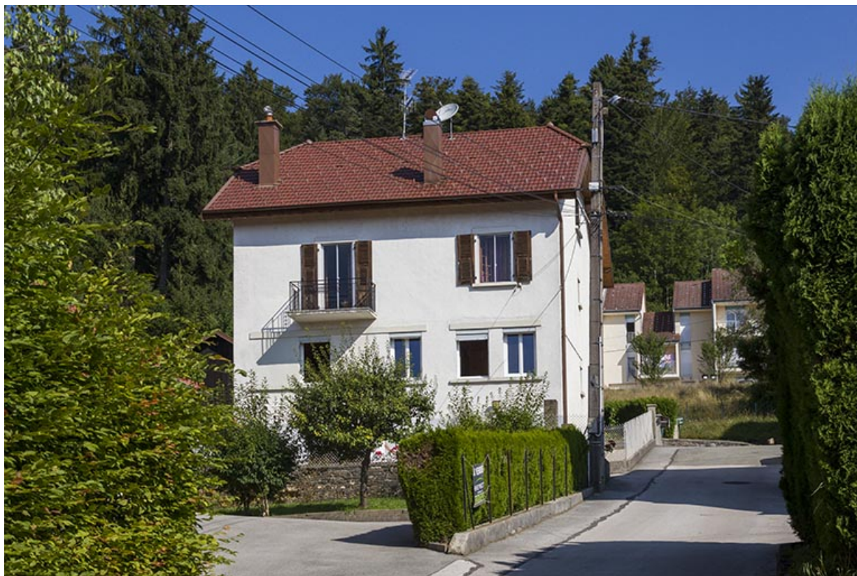
Vue d'ensemble, depuis le sud.
