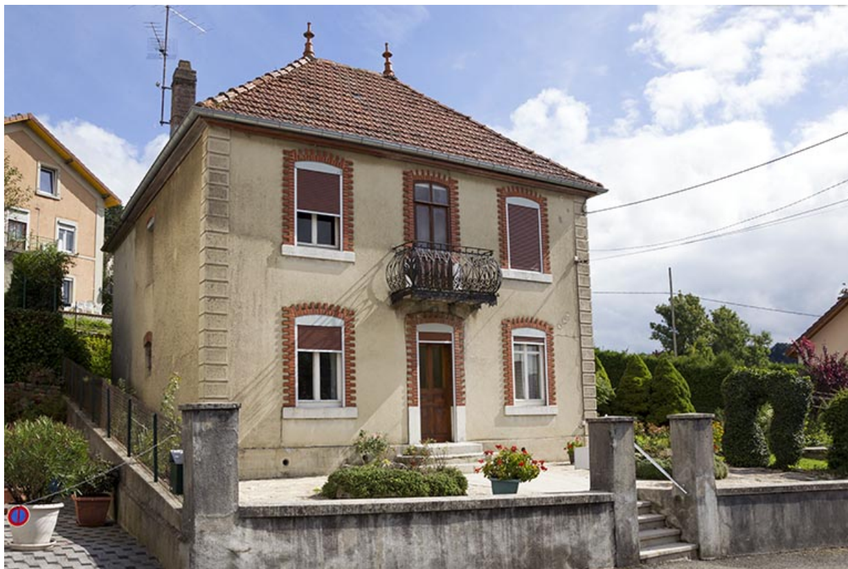
Maison : façade antérieure, de trois quarts gauche.
