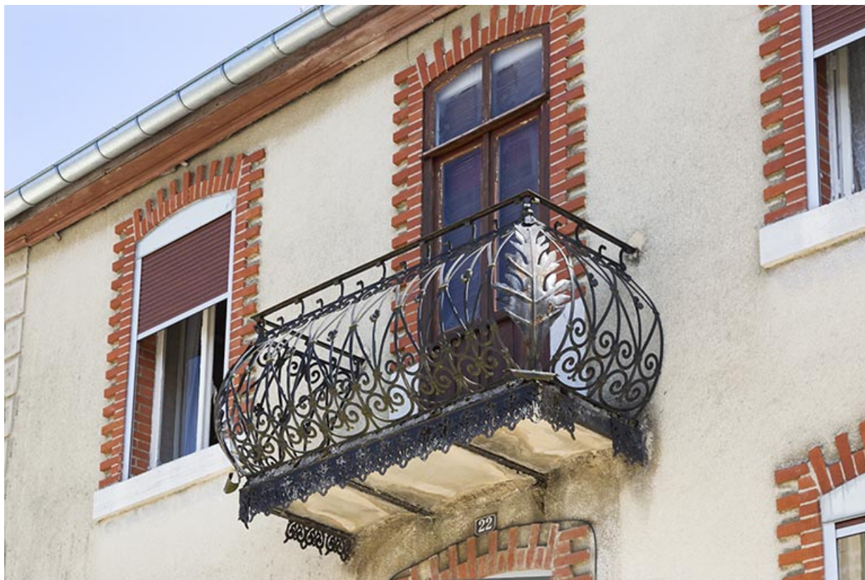
Maison, façade antérieure : balcon, vu en contre-plongée.
