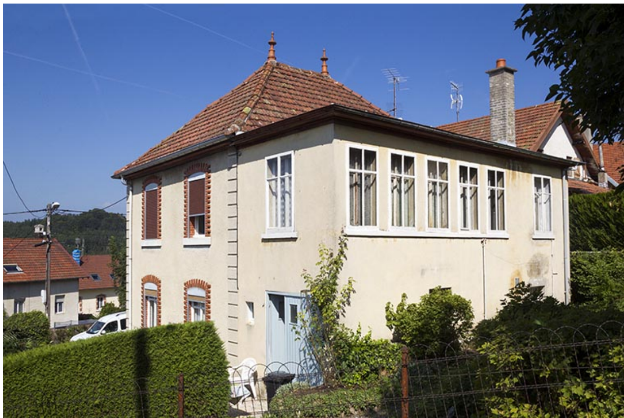
Vue d'ensemble, depuis l'est (façade latérale droite de la maison et atelier de fabrication). 25, Maîche
