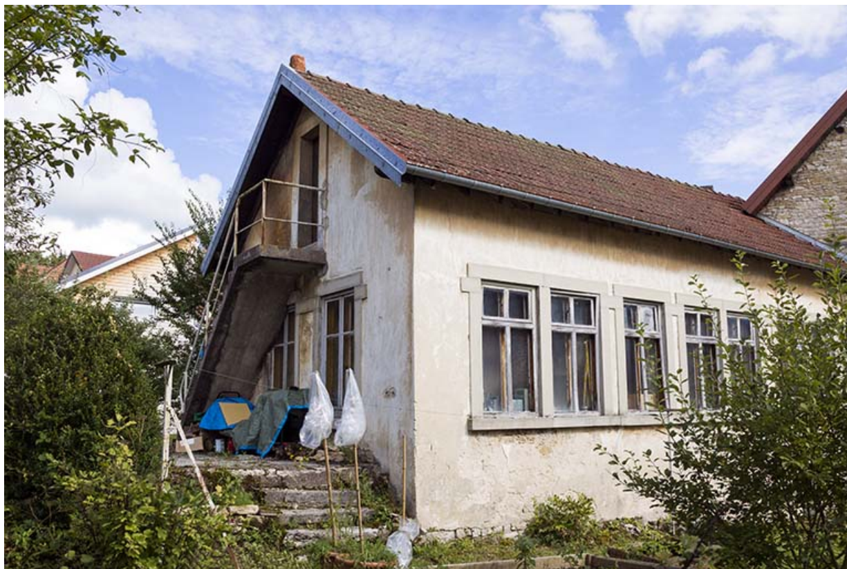
Usine : façades postérieure et latérale droite. 25, Maîche, 19 rue du Mont Miroir
