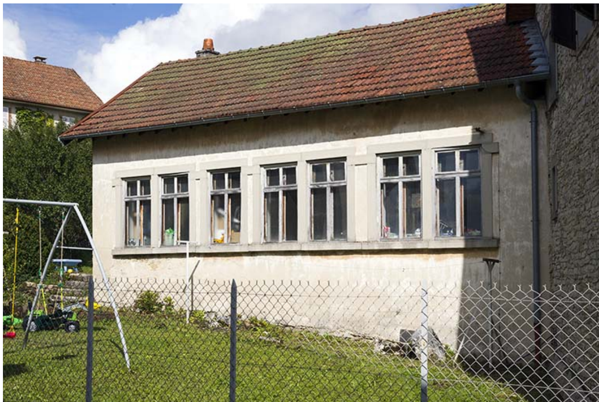
Usine : façade postérieure, de trois quarts droite. 25, Maîche, 19 rue du Mont Miroir
