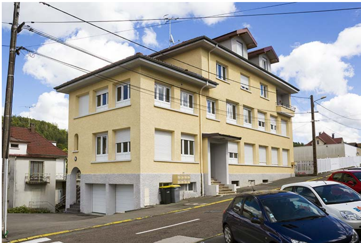
Façades antérieure et latérale gauche.
