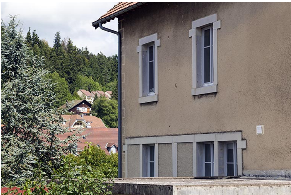
Façade latérale gauche : fenêtres multiples.
