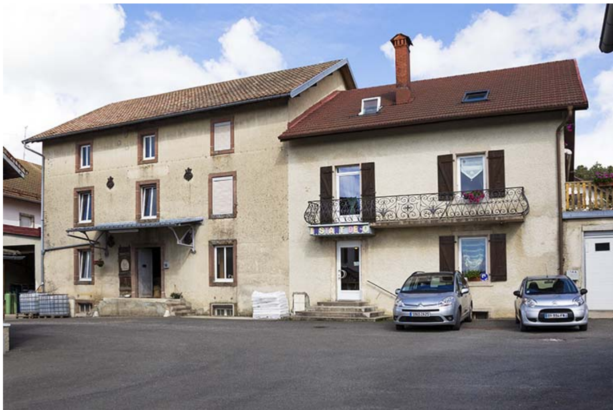
Minoterie et logement patronal : façade antérieure, de trois quarts droite.
