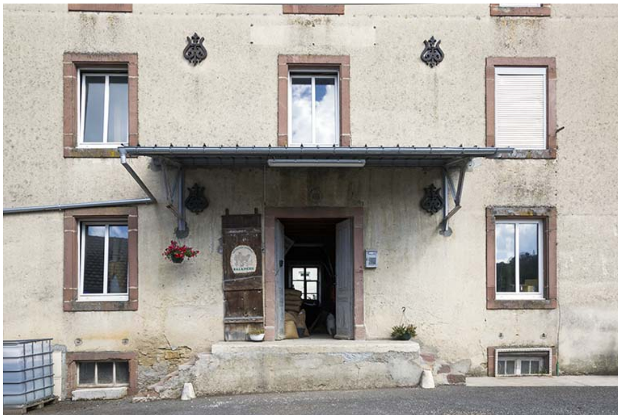
Minoterie : partie centrale de la façade antérieure.
