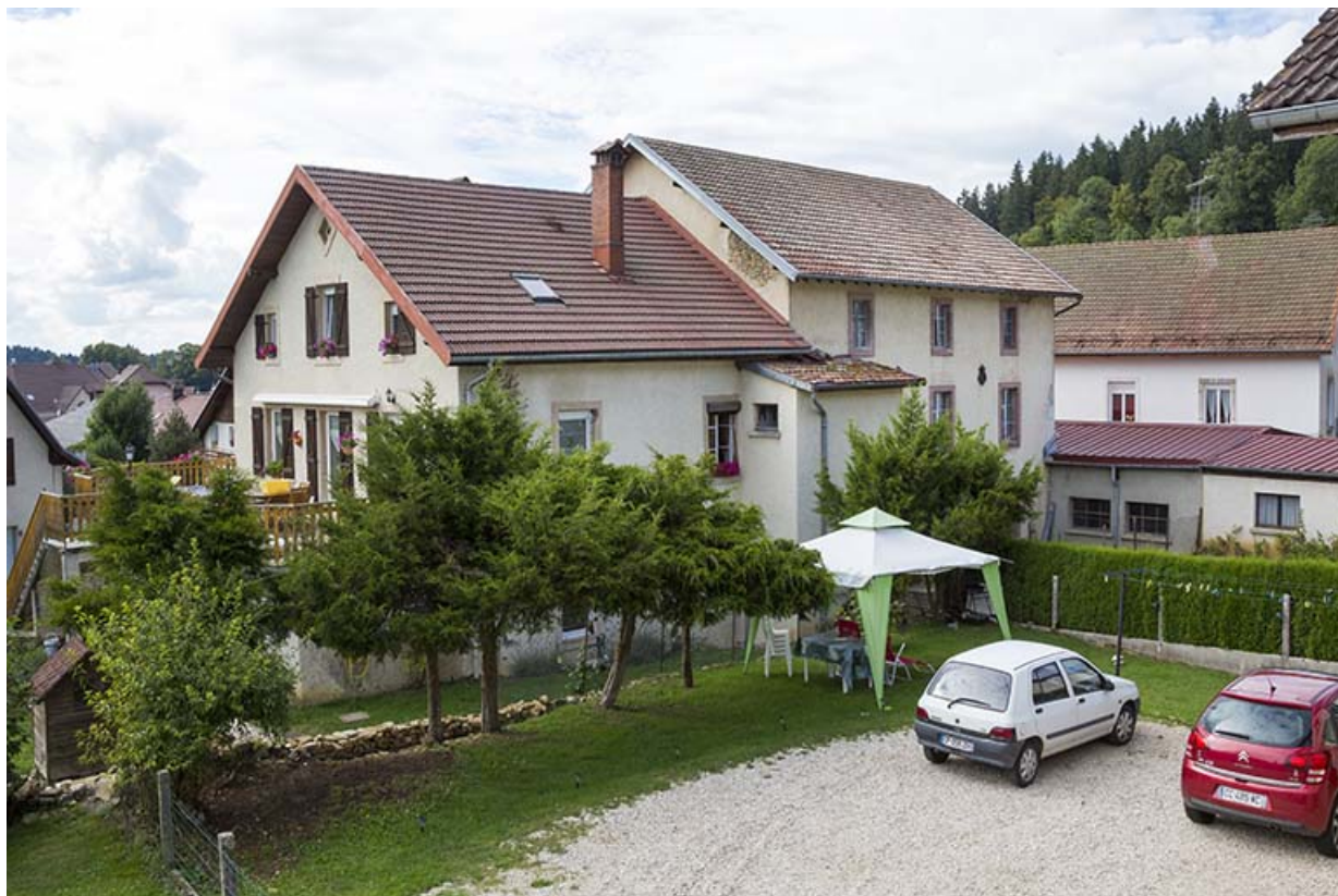
Vue d'ensemble, depuis le sud-est (logement patronal, minoterie, garage et entrepôt de vin). 25, Maîche, 12 et 14 rue du Mont Miroir
