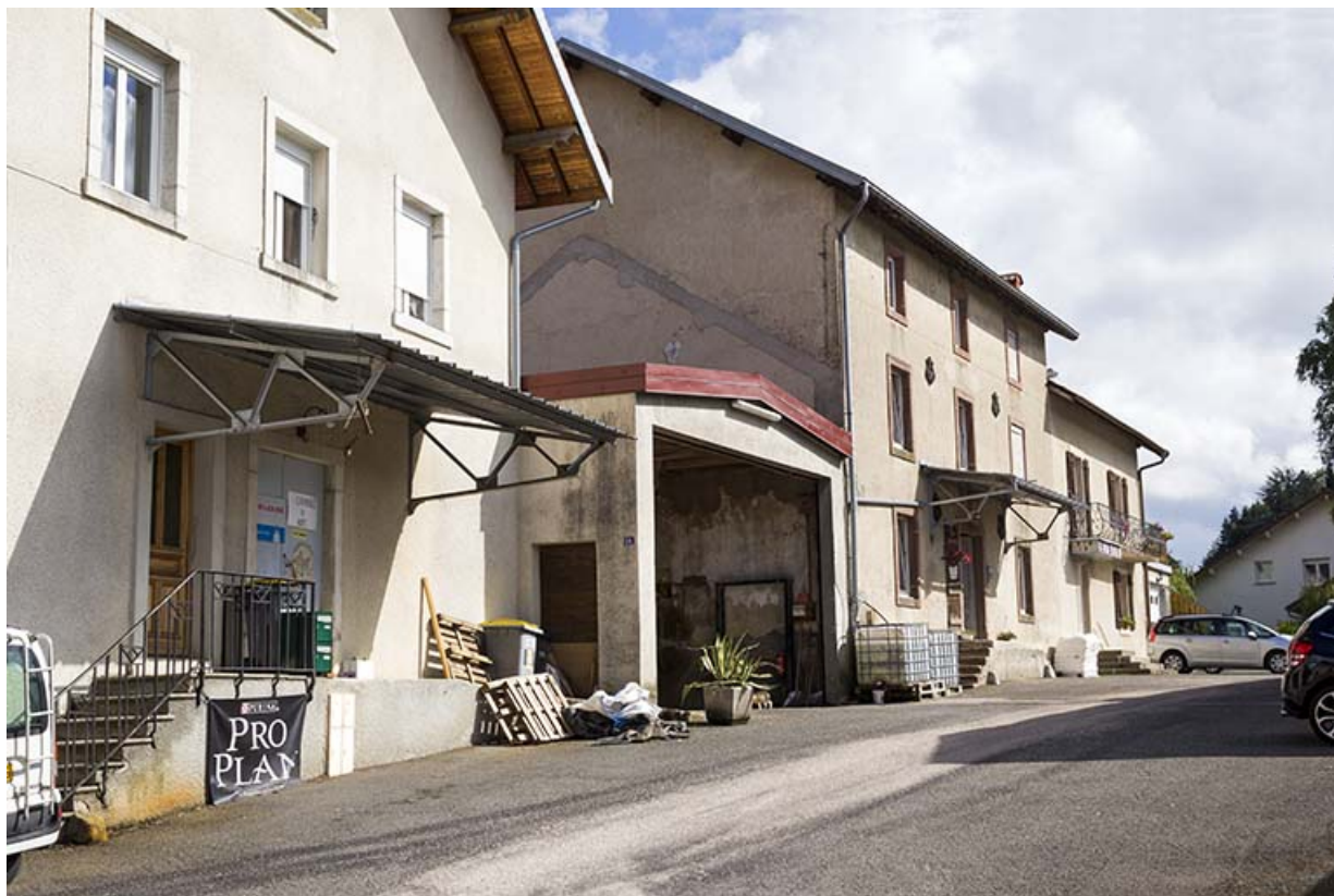
Entrepôt de vin, garage, minoterie et logement patronal.
