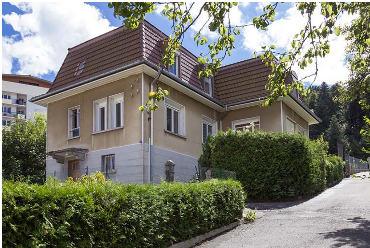
Façades antérieure et latérale droite.
