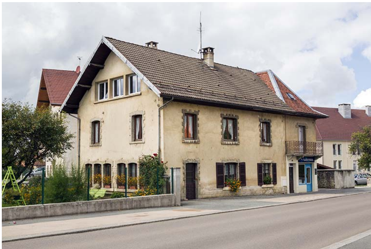
Façades antérieure et latérale gauche.
