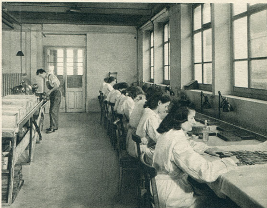
MAICHE Préparation des pierres pour le perçage
