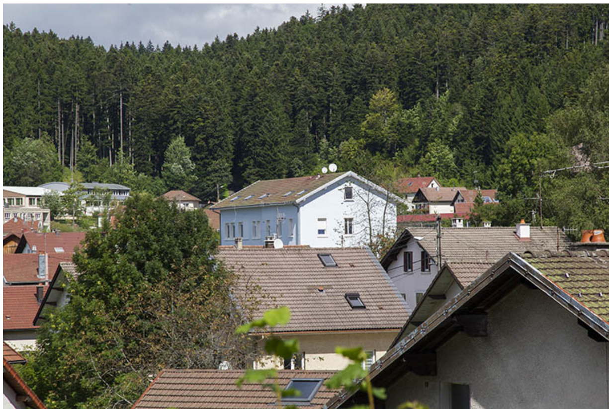
Vue d'ensemble éloignée, depuis le sud.
