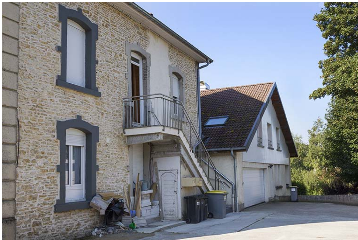
Logement : façade latérale droite.
