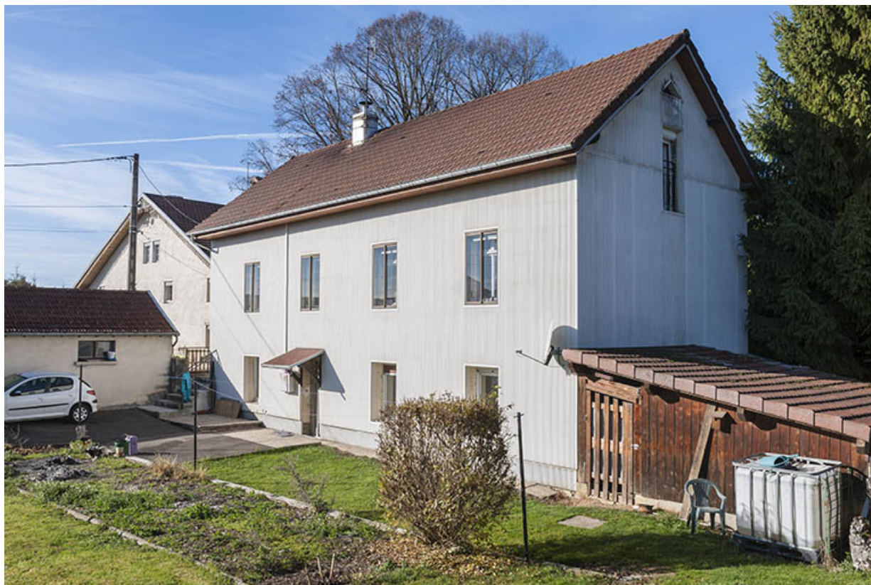
Atelier de fabrication (au n° 6), de trois quarts droite.
