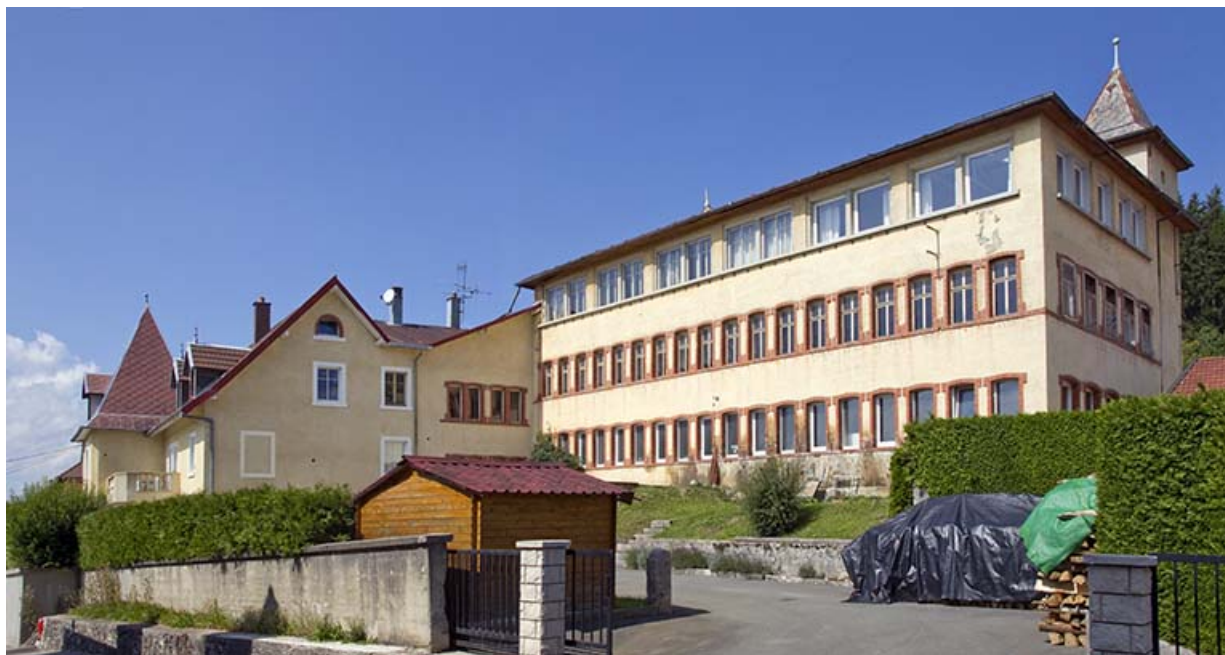
Vue d'ensemble, depuis la rue du Mont à l'est.
