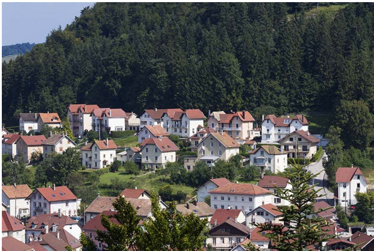
Vue d'ensemble du quartier de Montjoie, depuis le sud.
