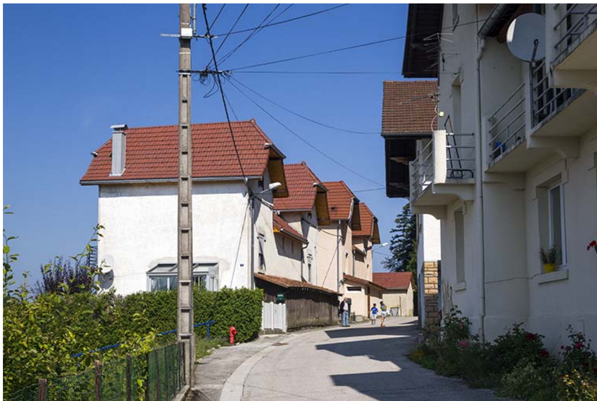
Immeubles n° 4 et 6 rue Montjoie : vue en enfilade côté rue, depuis le sud-ouest. 25, Maîche, 7-9 rue du Mont
