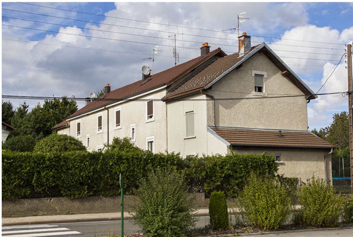
Immeuble au n° 11 avenue du Maréchal Leclerc : vue d'ensemble, depuis le sud-ouest.
