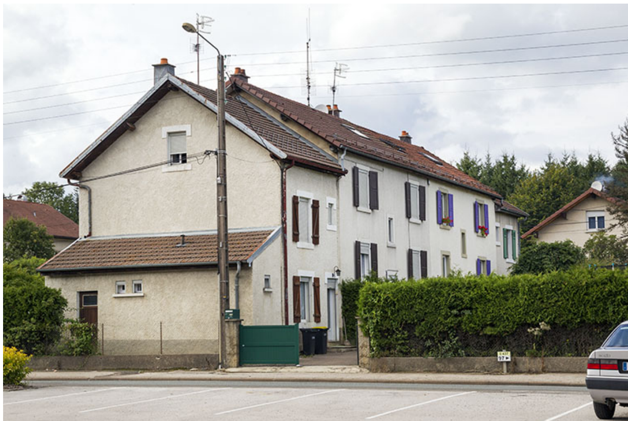
Immeuble au n° 11 : vue d'ensemble, depuis le sud-est.
