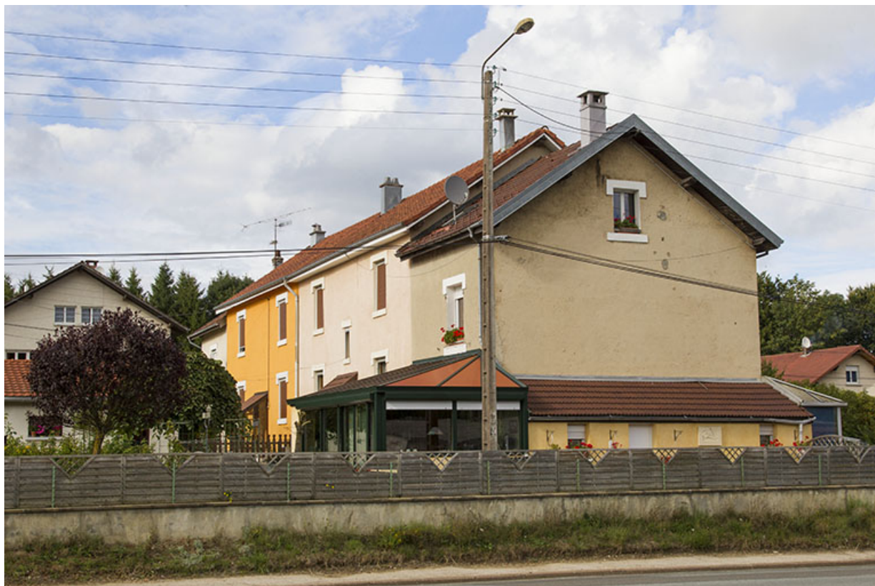
Immeuble au n° 9 : vue d'ensemble rapprochée, depuis le sud-ouest.
