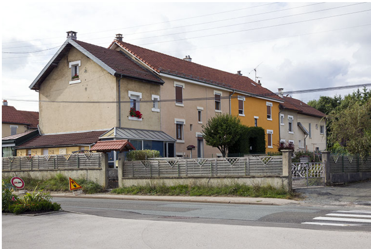
Immeuble au n° 9 : vue d'ensemble, depuis le sud-est.
