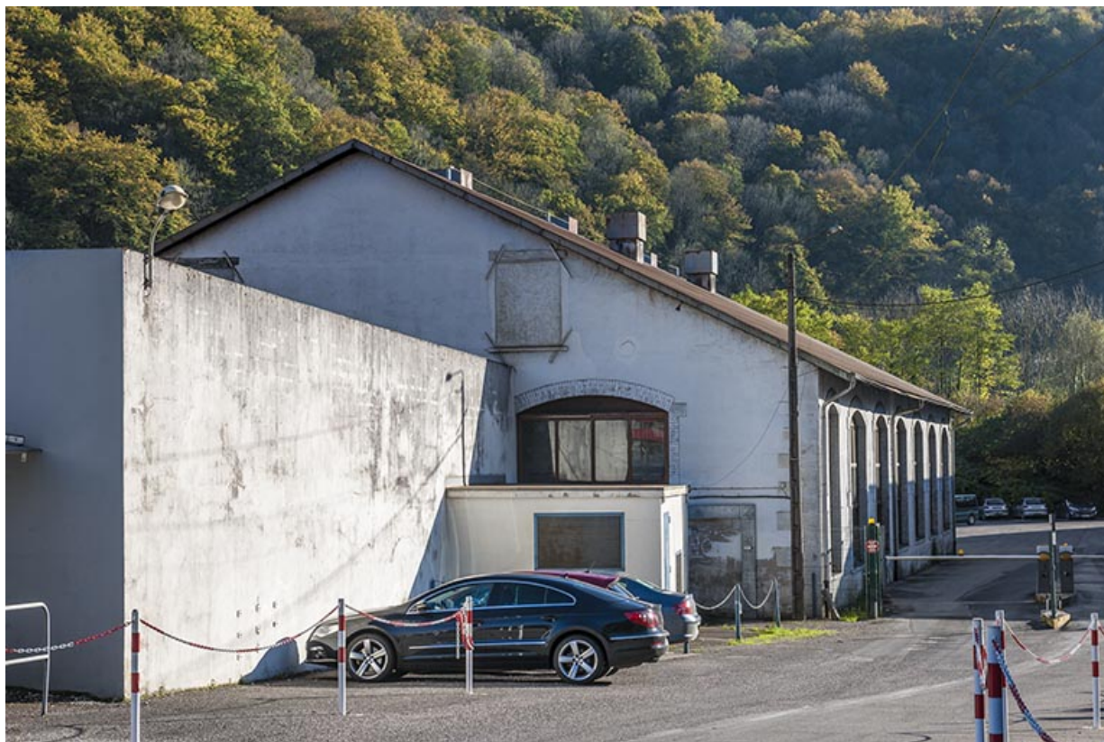
Ancien atelier de forge (marteaux pilons). 25, Laissey rue Elysée Bost
