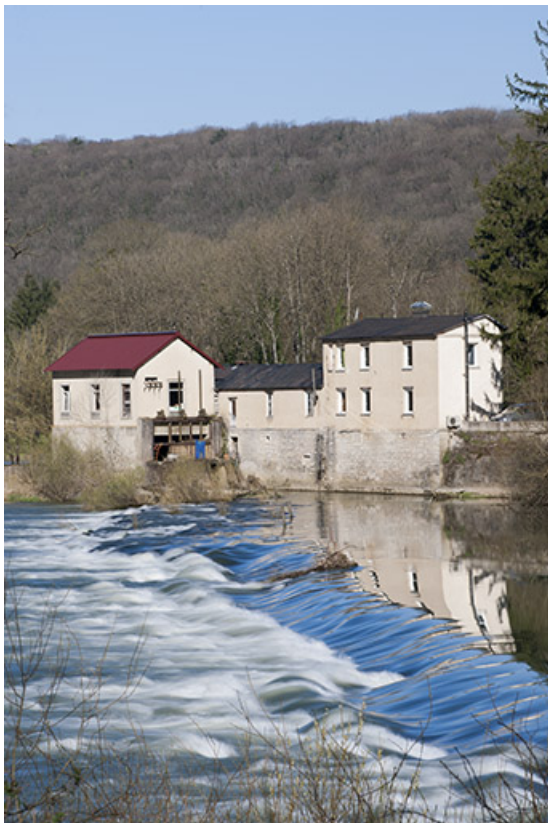
Vue depuis la rive gauche du barrage.
