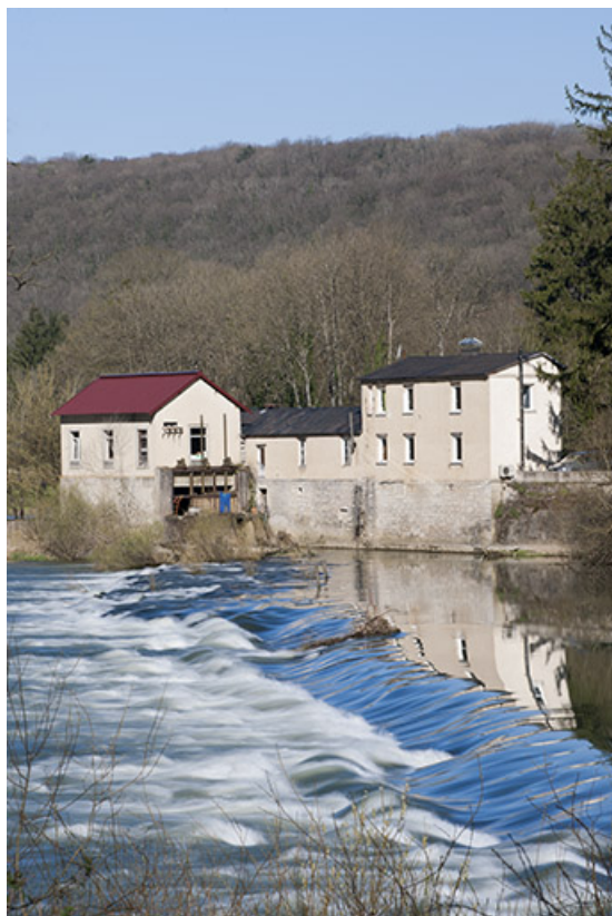
Vue depuis la rive gauche du barrage.
