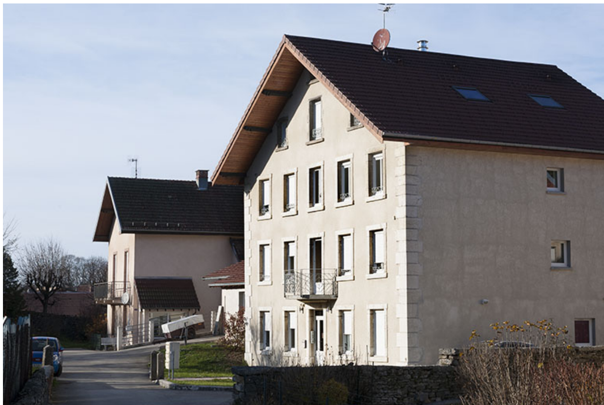
Vue d'ensemble, depuis la rue Sainte-Anne. 25, Maîche, 6 rue Sainte-Anne
