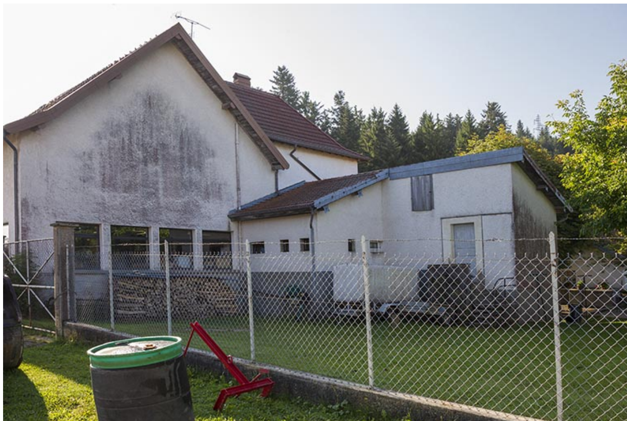
Atelier de fabrication (façade postérieure) et dépendance.
