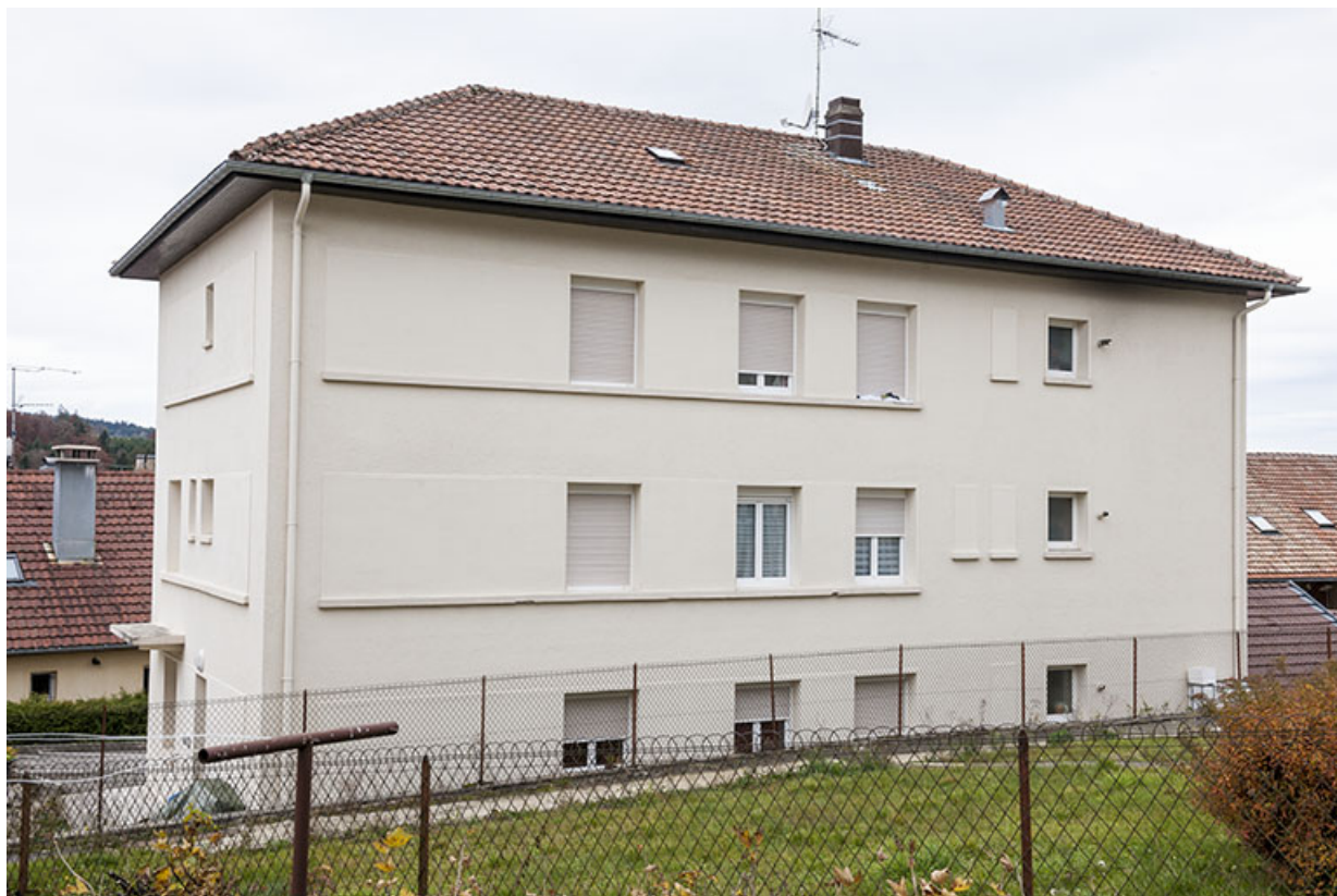
Usine : façades postérieure et latérale droite. 25, Maîche
