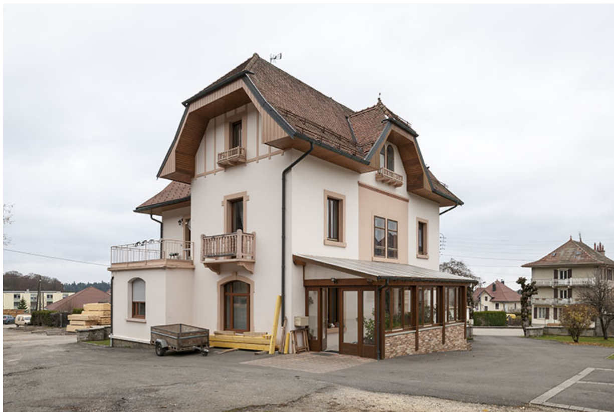
Logement patronal : façades sud et est. 25, Maïche rue de la Scierie
