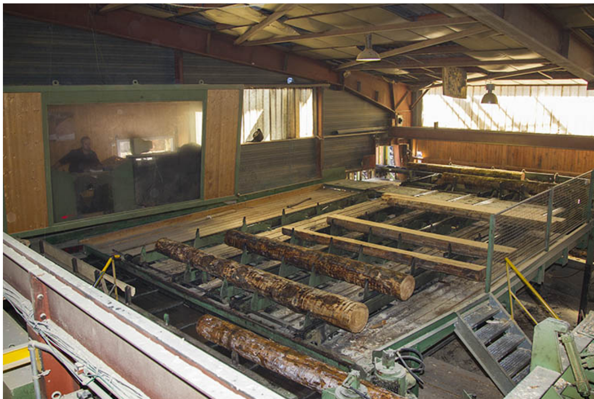
Atelier de débitage (N) : poste de commande et convoyeur de grumes. 25, Maïche rue de la Scierie
