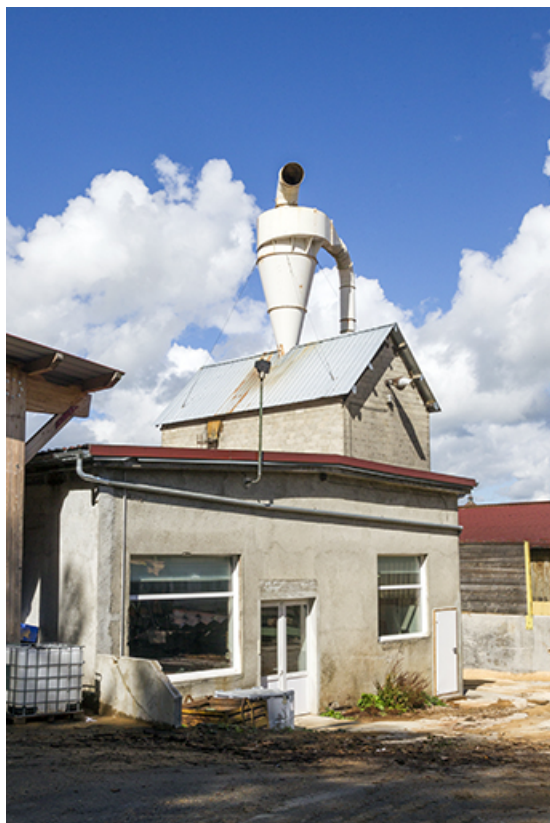
Atelier d'affûtage (K), entre l'atelier de trempage (J) à gauche et le silo à sciure (L) en arrière-plan. 25, Maïche rue de la Scierie
