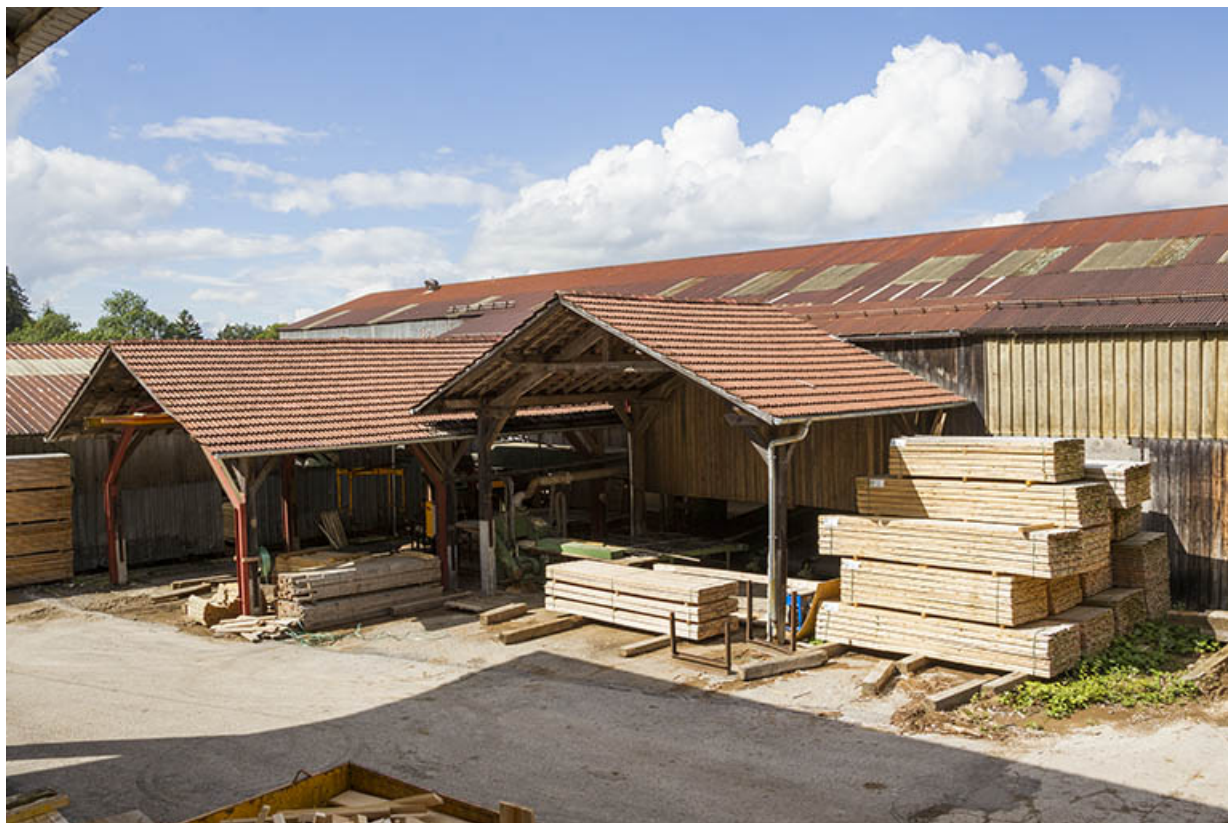
Hangars au sud, adossés aux ateliers F (empilage) et M (débitage). 25, Maïche rue de la Scierie
