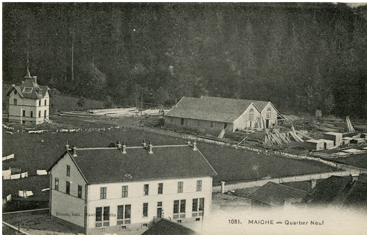
1081. Maïche - Quartier neuf [vue rapprochée depuis le clocher de l'église, au nord-ouest], 1er quart 20e siècle. 25, Maïche rue de la Scierie
