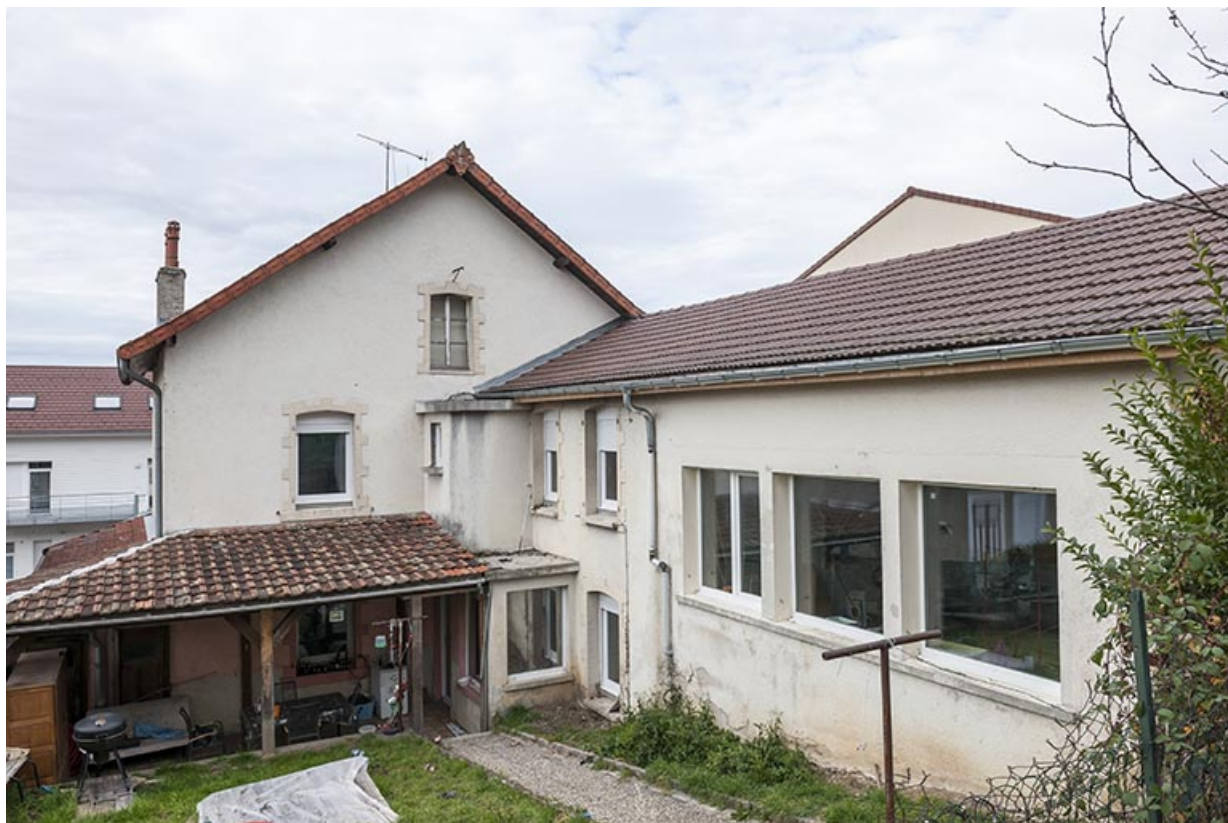
Logement (façade postérieure) et atelier.
