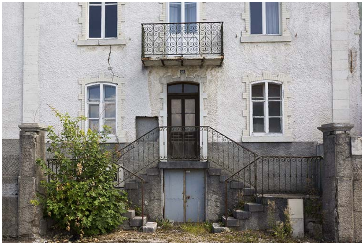
Bâtiment des années 1914-1918 : escalier sur la façade antérieure.
