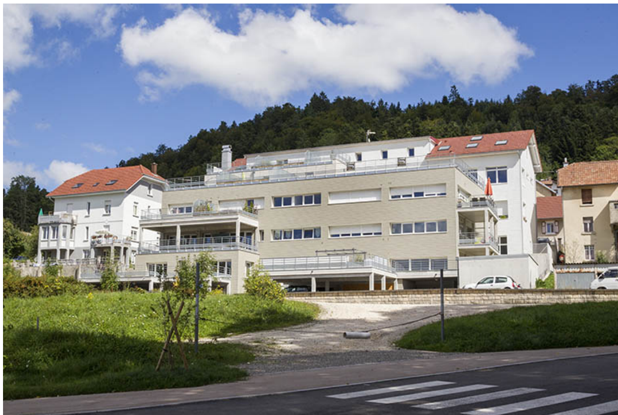
Bâtiments du 3e quart du 20e siècle : façade postérieure, de trois quarts droite (sud-ouest). 25, Maîche, 19, 21, 26 rue de Saint-Hippolyte
