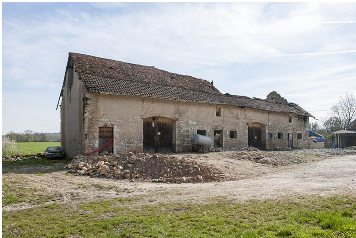
Bâtiment agricole vu de trois quarts gauche. 25, Moncley rue du Moulin
