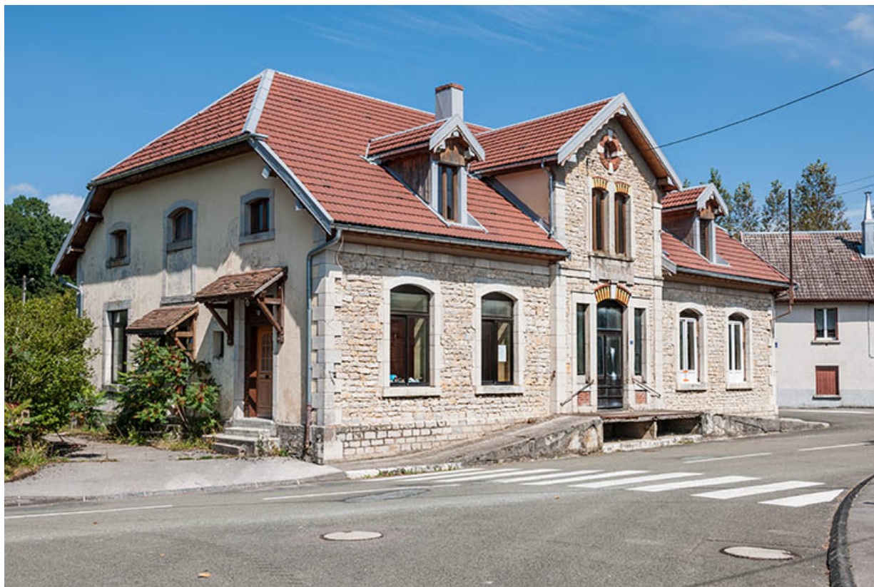
Vue de trois quarts gauche. 25, Vanclans, 8 Grande Rue
