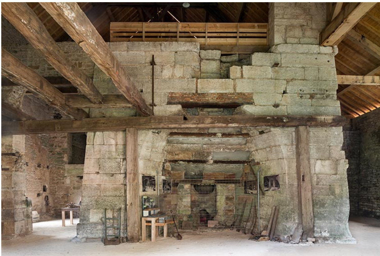
Haut fourneau, vu de face.
