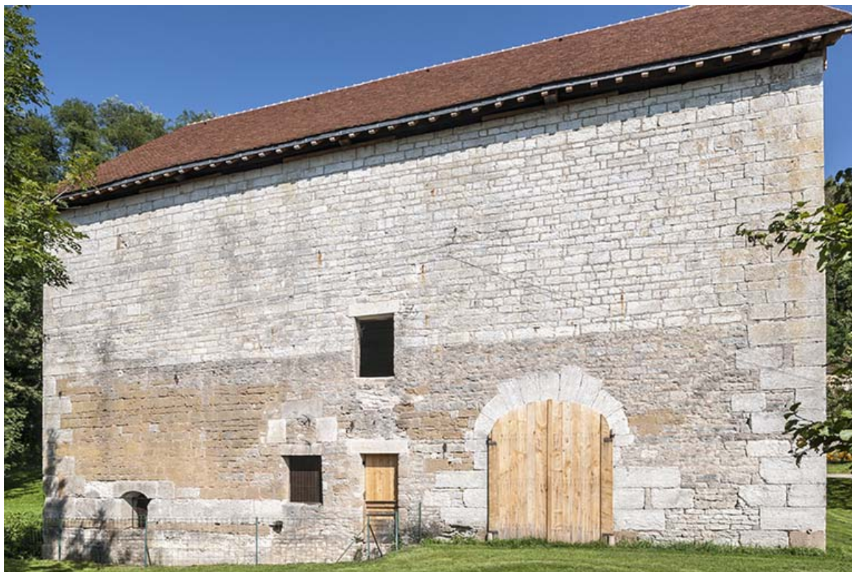
Façade sud du bâtiment du haut fourneau.
