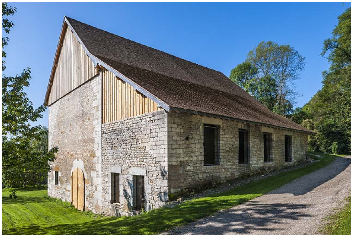
Bâtiment du haut fourneau vu de trois quarts gauche.
