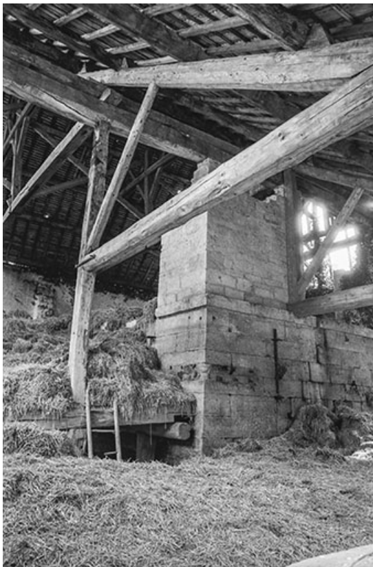
Partie supérieure du haut-fourneau.
