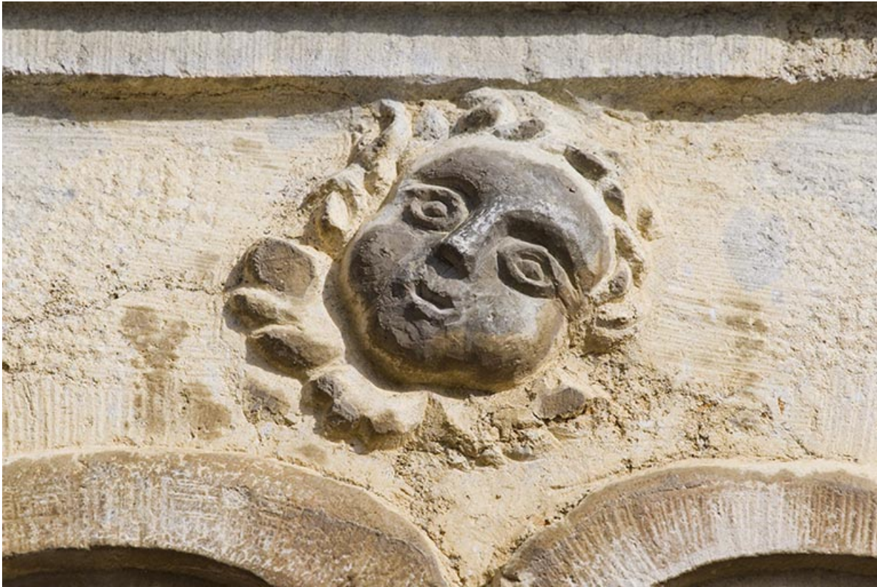
Maison : tête d'angelot sur le linteau de la porte d'entrée.
