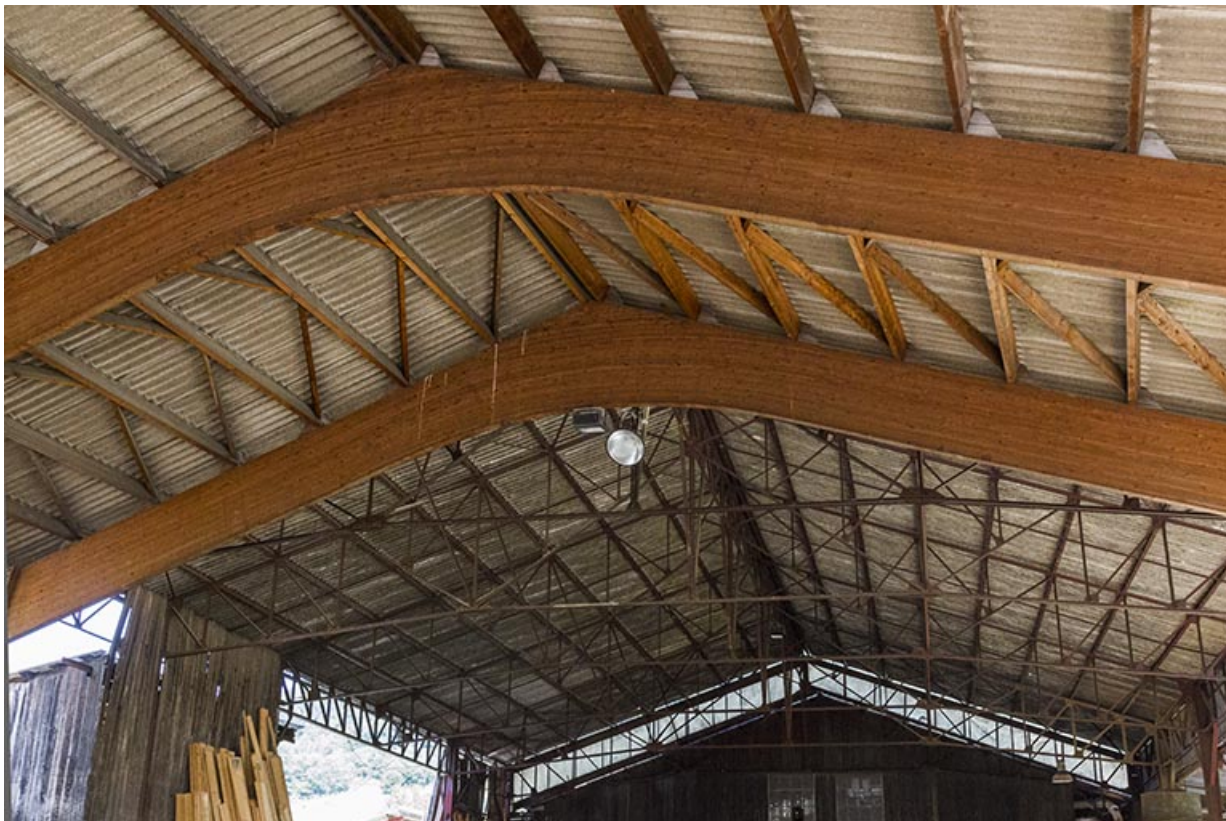
Hangar de 1990 : charpente en lamellé-collé. 25, Cour-Saint-Maurice, 10 Rue Grande
