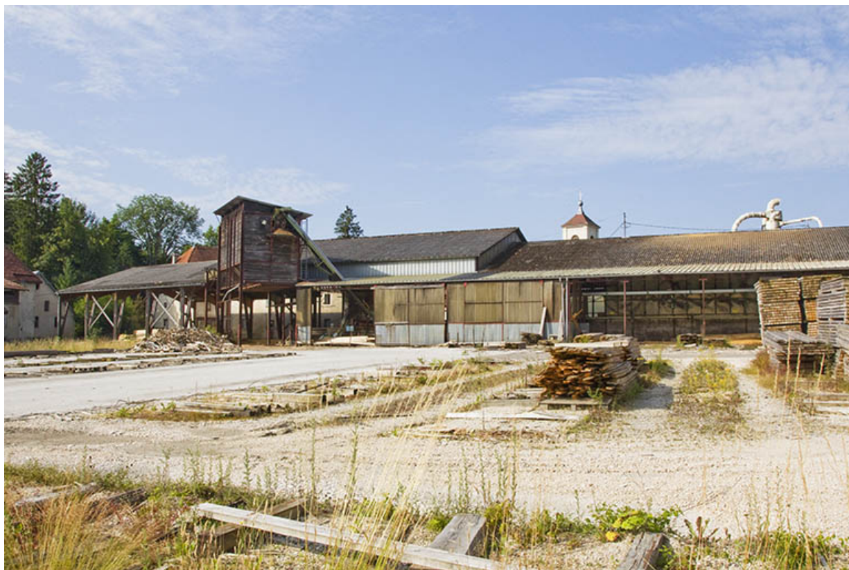
Scierie vue de l'est : de gauche à droite, hangars de 1990 et 1969-1970, atelier de fabrication de 1953. 25, Cour-Saint-Maurice, 10 Rue Grande
