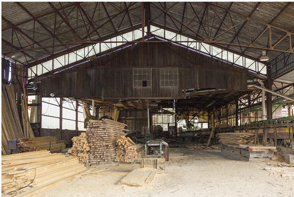
Hangar de 1969-1970 et atelier de fabrication de 1953 : intérieur.
