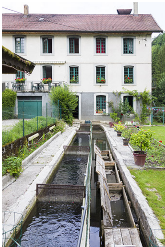
Moulin, façade antérieure : bief d'amenée transformé en vivier.
