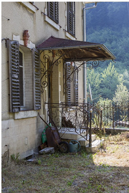
Logement patronal de 1900, façade latérale droite : entrée et auvent. 25, Vaucluse, lieudit : le Moulin du Milieu
