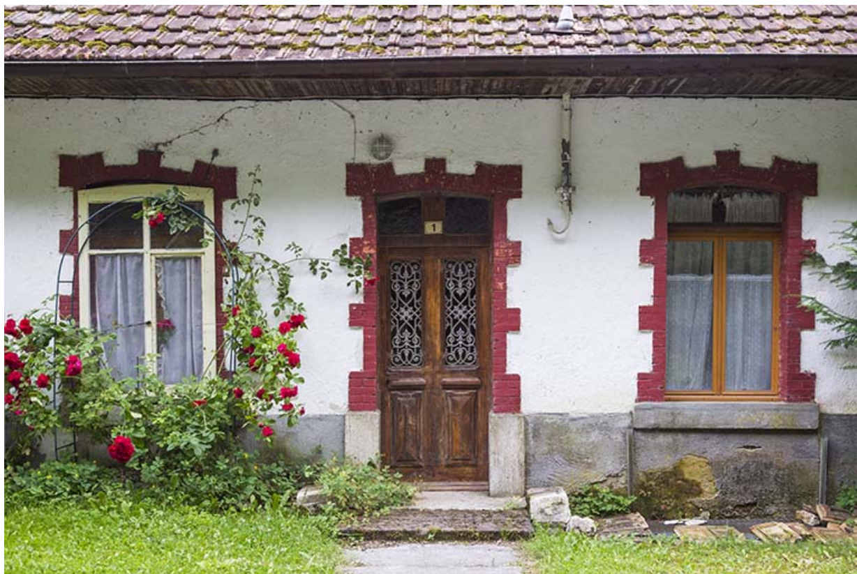
Logements d'ouvriers : façade antérieure du logement nord.
