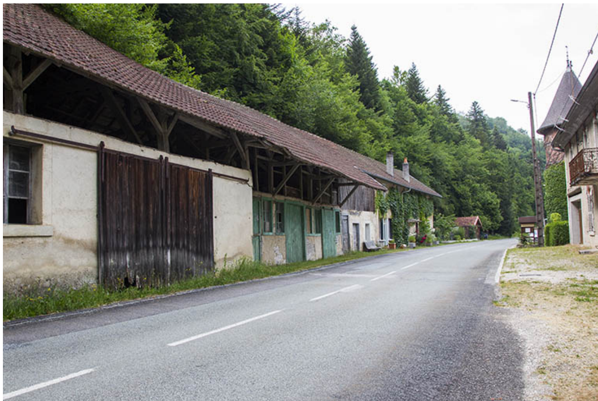
Logements d'ouvriers, écuries et remises, depuis le sud.
