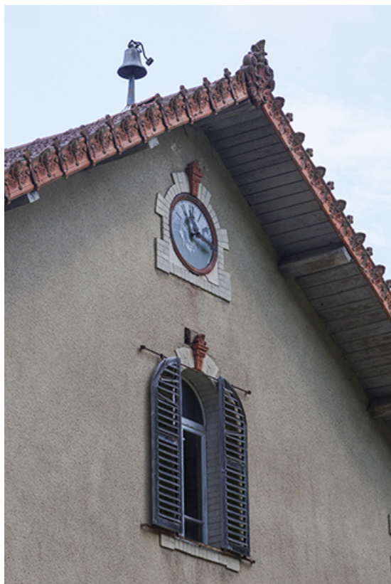
Logement patronal de 1900, façade latérale droite : fenêtre, horloge et cloche. 25, Vaucluse, lieudit : le Moulin du Milieu
