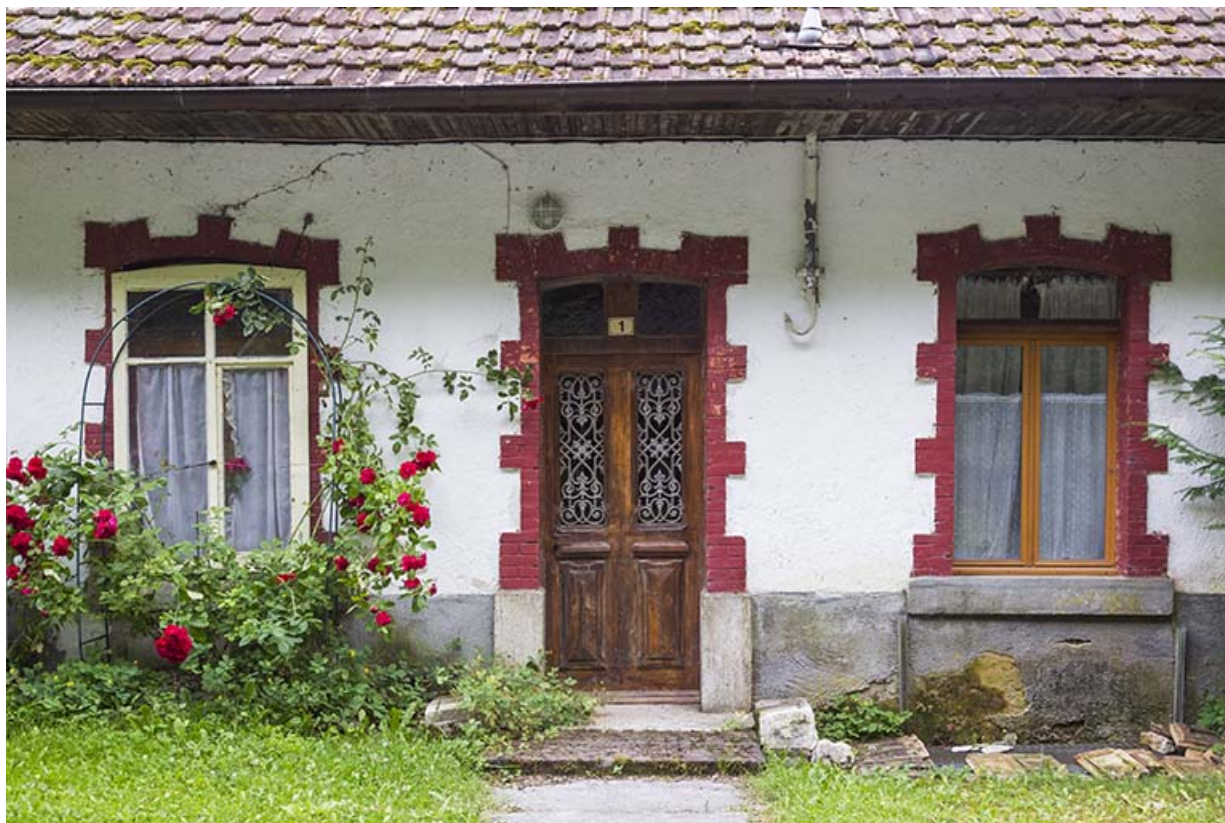
Logements d'ouvriers : façade antérieure du logement nord.
