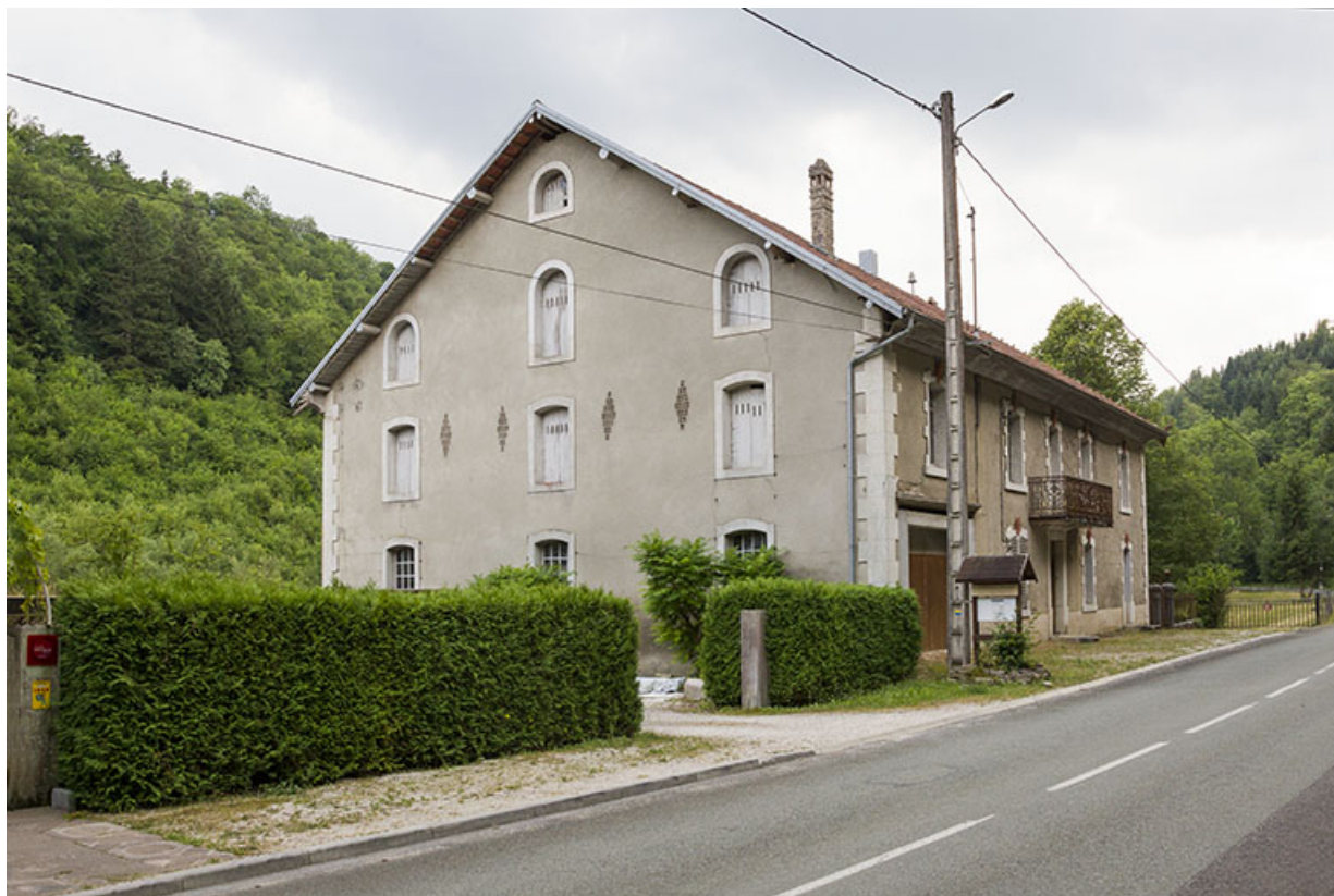
Logement patronal de 1900 : façades antérieure et latérale gauche.
