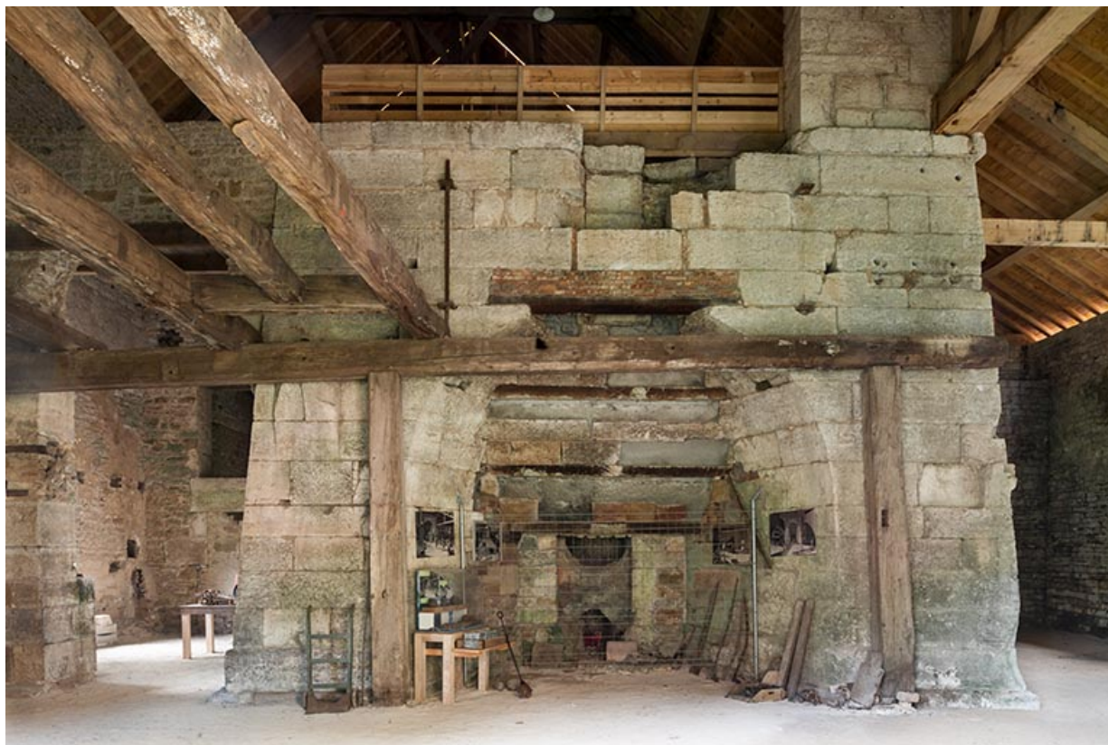
Haut fourneau, vu de face.
