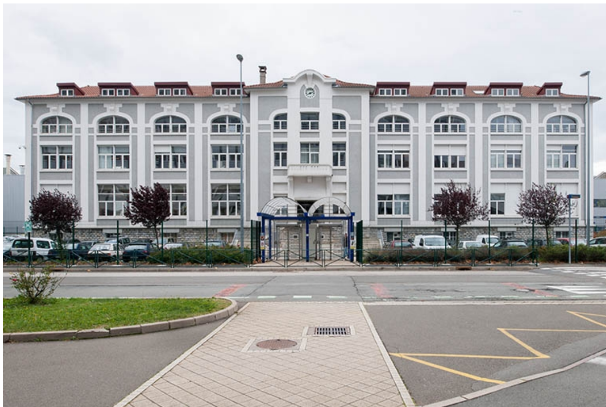
Bâtiment du Cercle. Vue de face.
