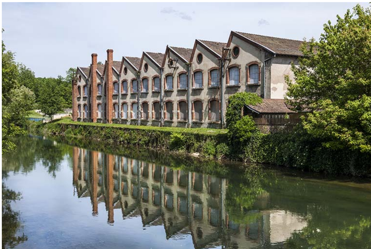
Façade ouest de l'atelier de fabrication.
