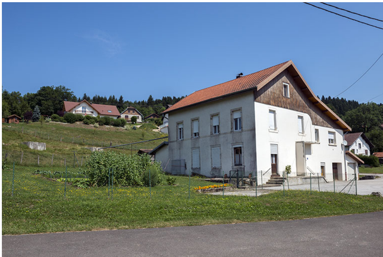
Vue d'ensemble, depuis le sud (élévations antérieure et latérale gauche). 25, Thiébouhans, 15 rue Principale
