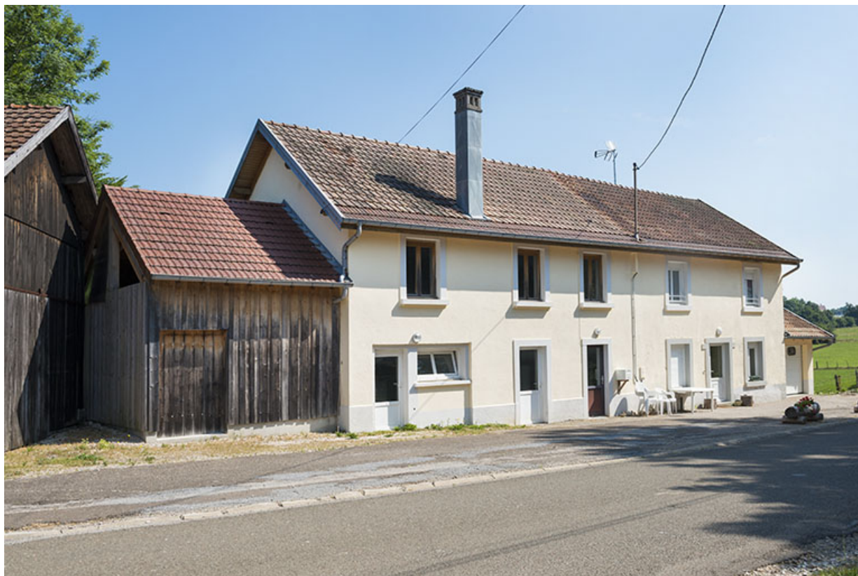
Façade antérieure, de trois quarts gauche. 25, Mont-de-Vougney, 2 rue de la Fromagerie
