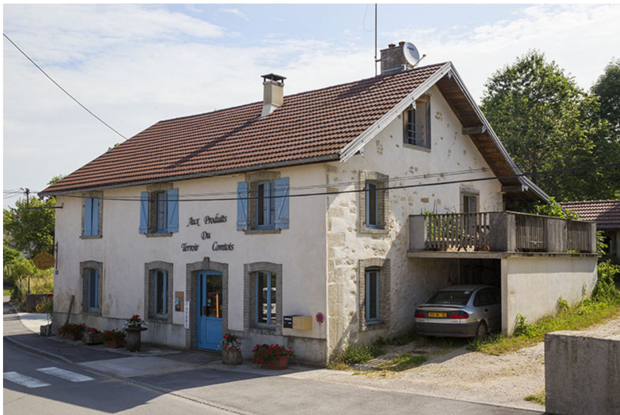
Façades antérieure et latérale droite.
