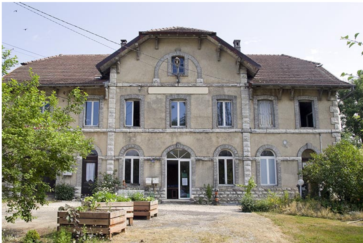
Façade antérieure : avant-corps central.
