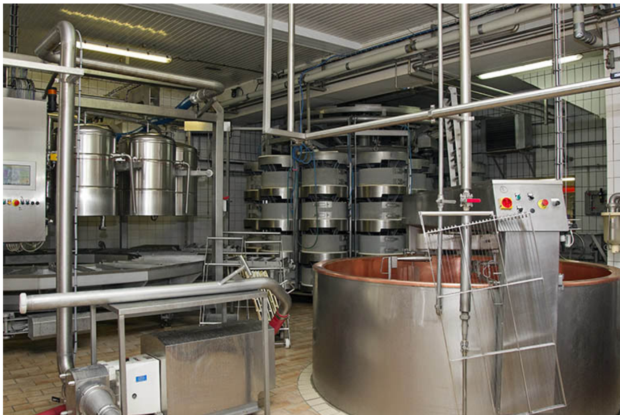
Intérieur de l'atelier de fabrication. Au premier-plan une cuve, au second le groupe de moulage (à gauche) et celui de pressage (à droite).
