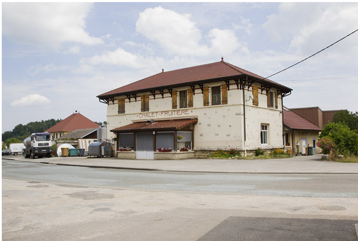
Façades antérieure et latérale droite.
