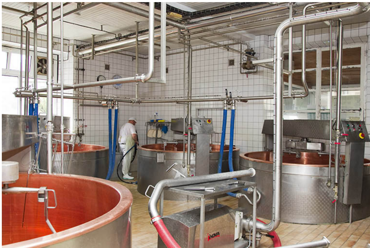
Intérieur de l'atelier de fabrication, avec quatre cuves.
