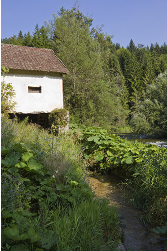
Centrale : extrémité sud de la façade postérieure et canal de fuite. 25, Battenans-Varin, 2 et 4 rue du Pont, lieudit : Varin
