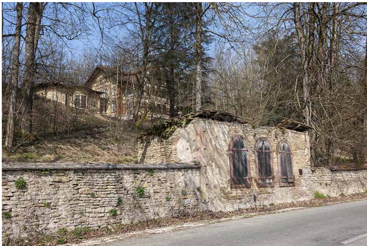
Au premier plan, local de la machine élévatoire du château d'eau. 25, Appenans route départementale 29
