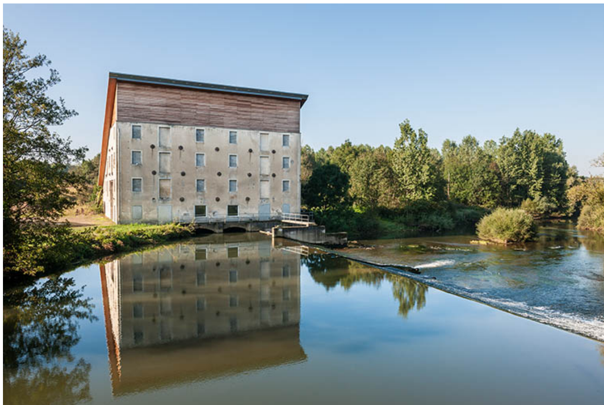
Vue d'ensemble depuis le pont.
