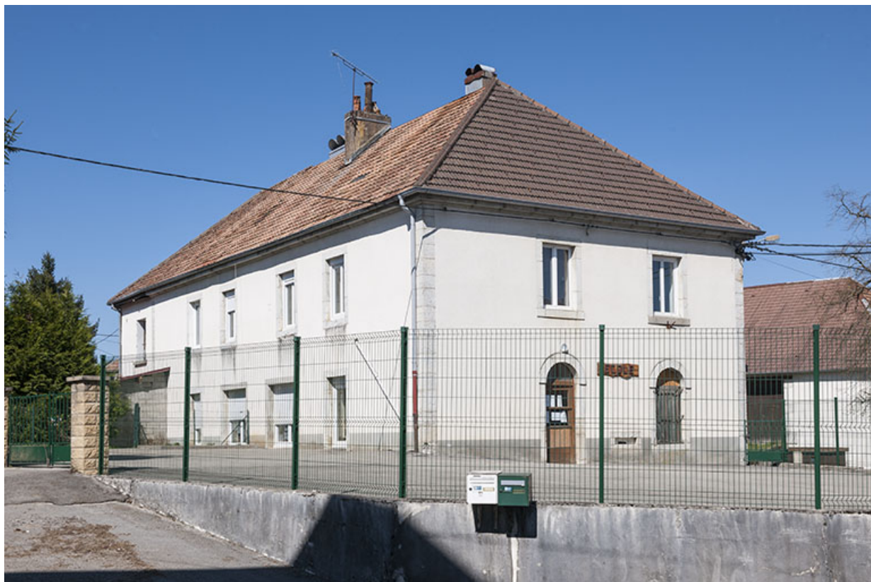
Vue depuis l'est (façade et pignon de l'école). 25, Fallérans, 22 Grande Rue
