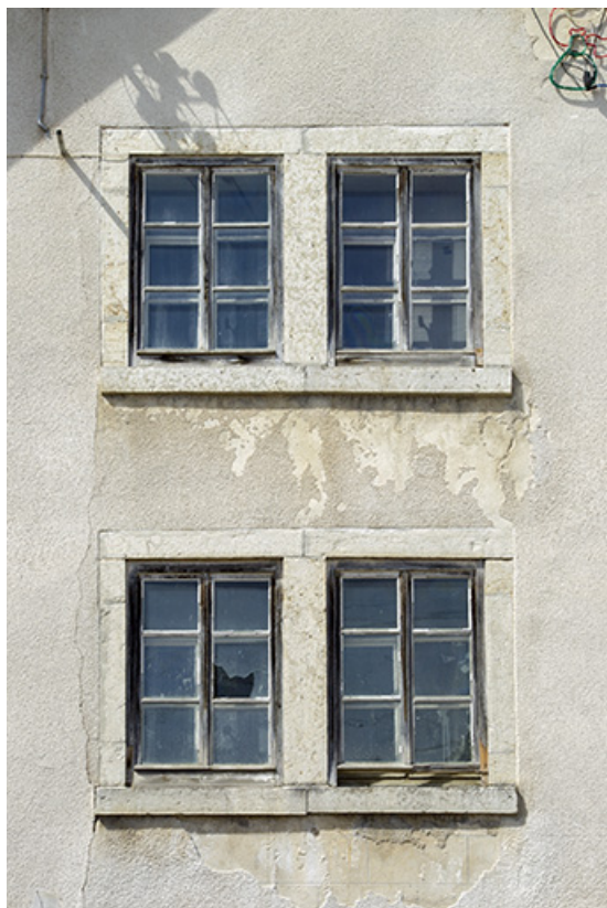
Façade latérale droite : fenêtres horlogères.
