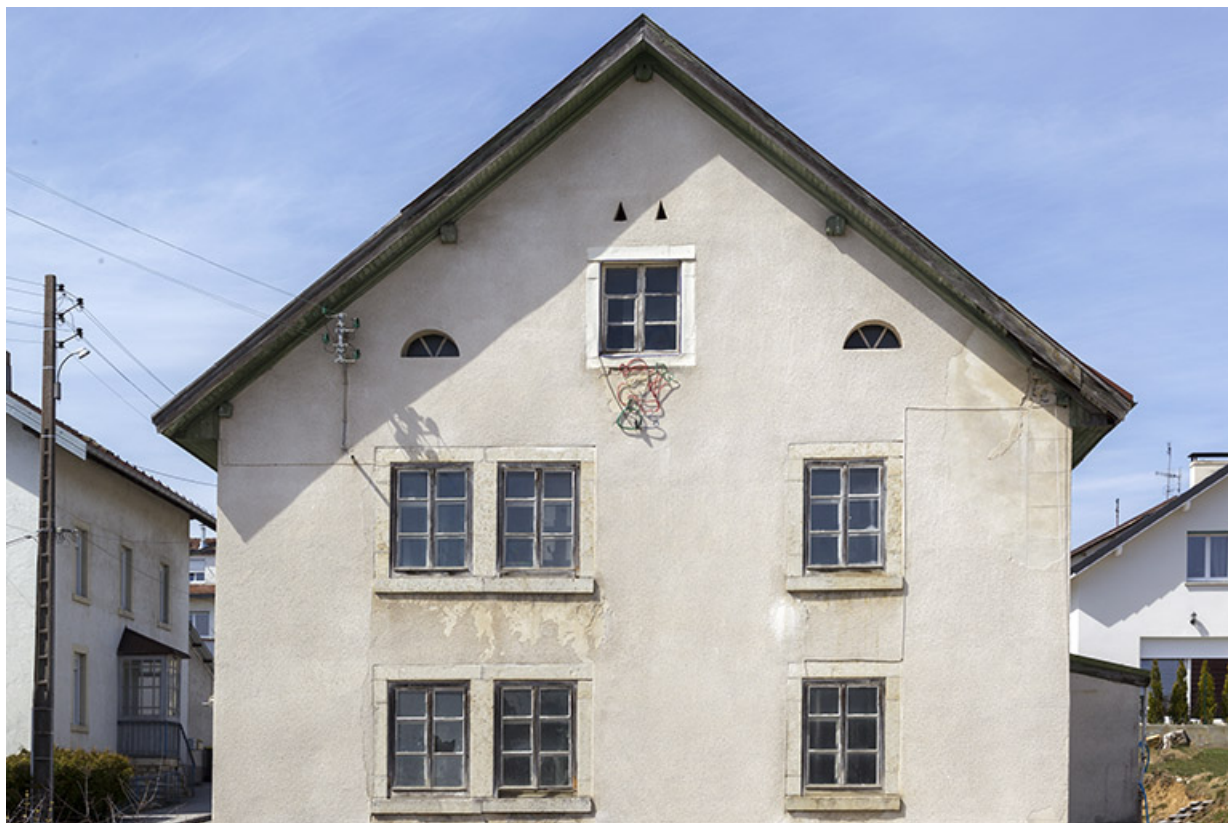
Façade latérale droite.
