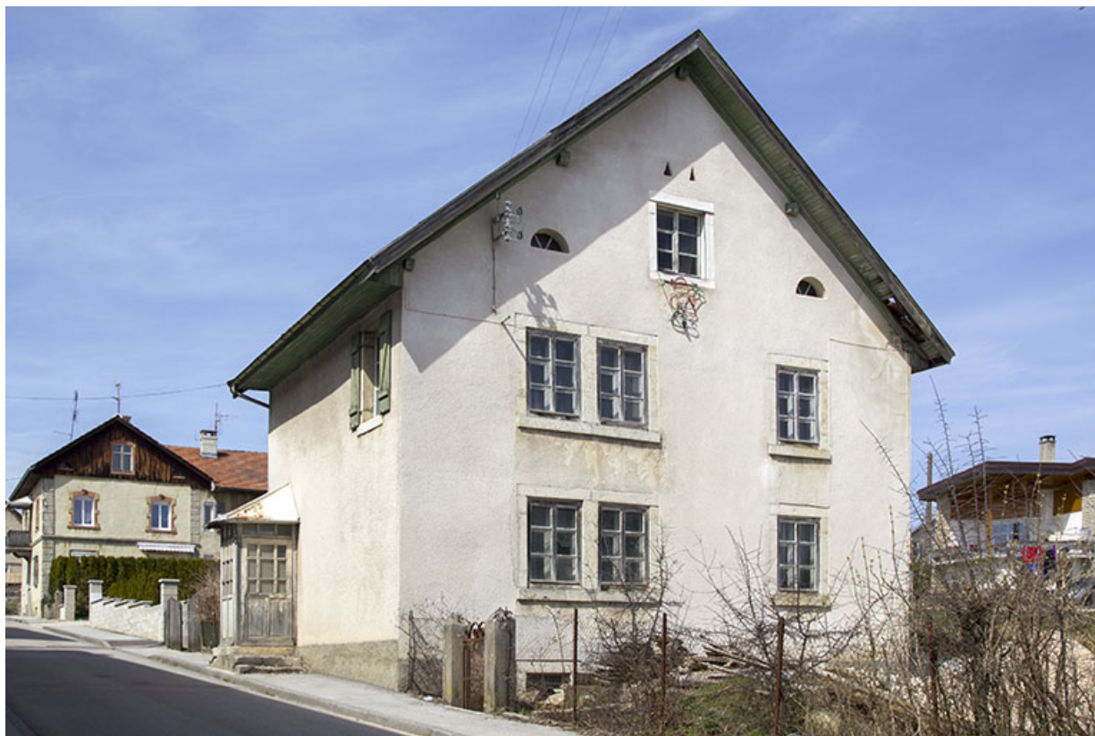
Façades antérieure et latérale droite.
