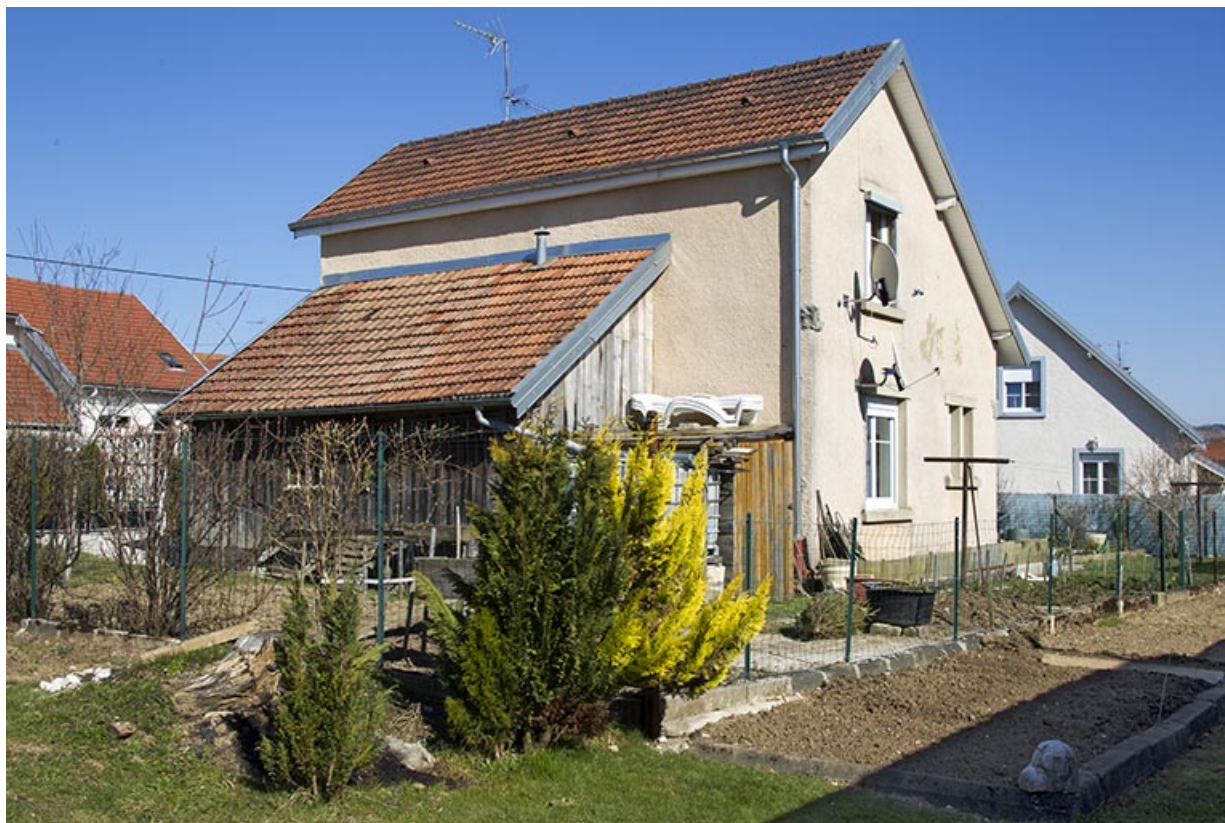
Façades postérieure (pignon) et latérale droite.
