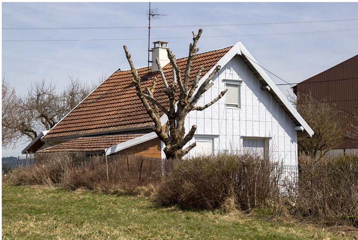
Façades postérieure et latérale gauche.
