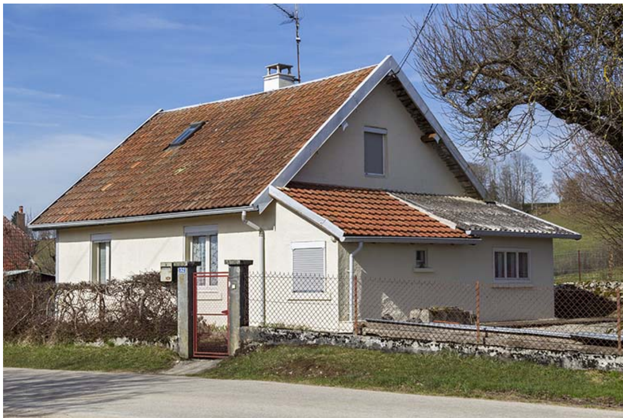
Façades antérieure et latérale droite.
