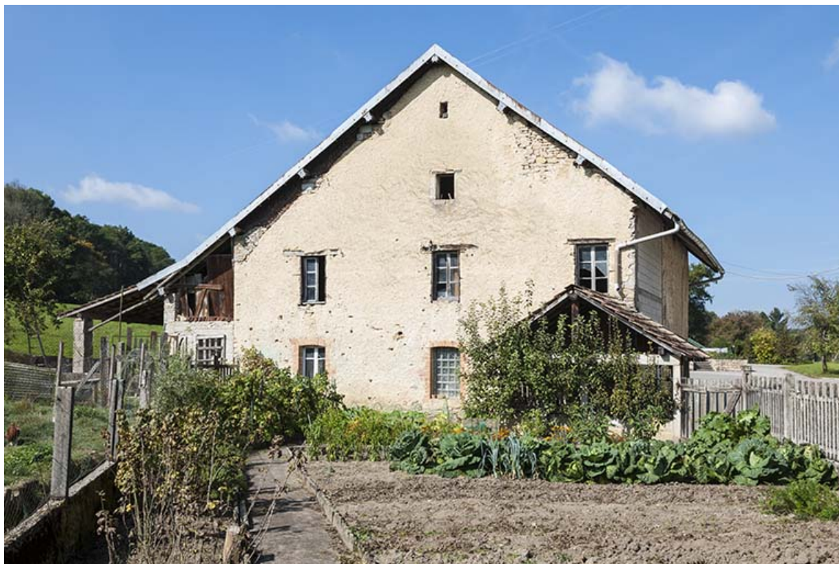
Vestige de la ferme, depuis le sud.
