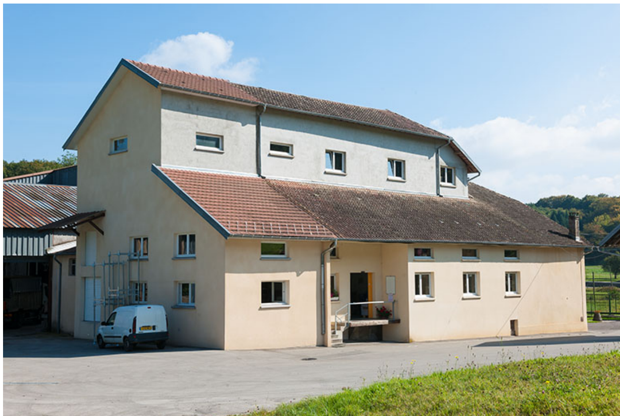
L'atelier du moulin, depuis le nord-est.
