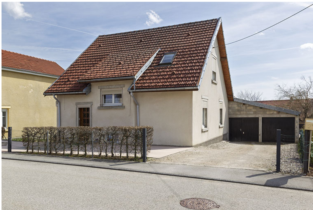
Vue d'ensemble, depuis le nord (façades antérieure et latérale droite). 25, Charquemont, 19 rue des Cités
